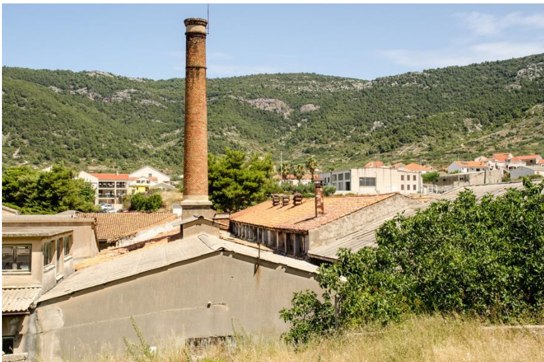
Slika 52. Dimnjak nekadašnje tvornice Neptun u Komiži, današnje stanje.
