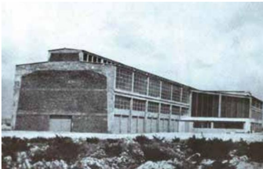
Slika 31. Dio Tvornice aluminija u Lozovcu, 1937.
