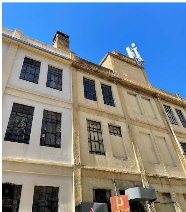
Slika 70. Zgrada nekadašnje tvornice tjestenine Cetina u Omišu, detalj bočnoga pročelja, 2022.
