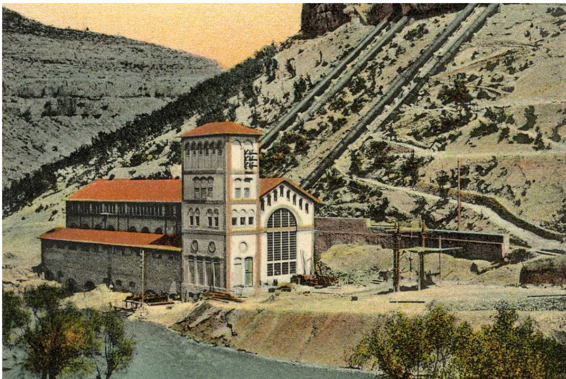
Slika 19. Hidroelektrana Manojlovac (Miljacka), stanje nakon izgradnje.
