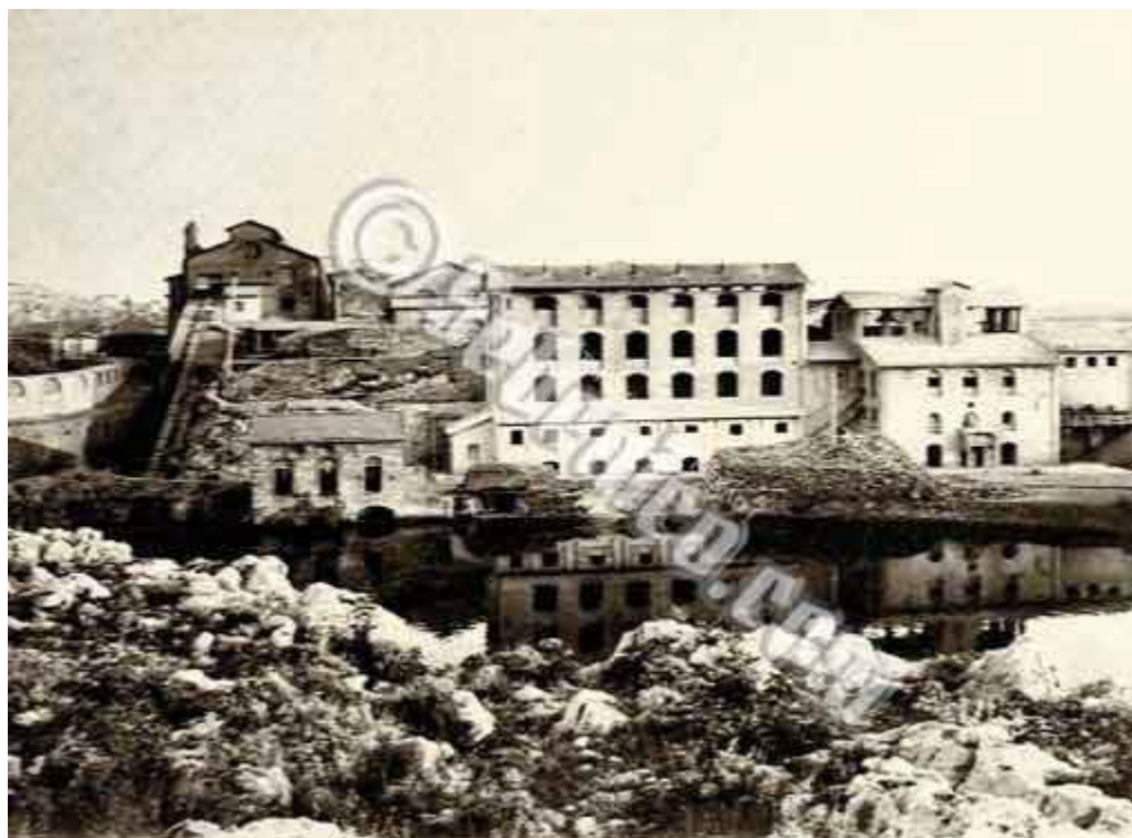
Slika 24. Tvornica SUFID u Crnici, oko 1910. – zgrade elektropeći za proizvodnju vapna, karbida i cijanamida. Na lijevoj strani nalazi se uspinjača za opskrbu peći sirovinama.
