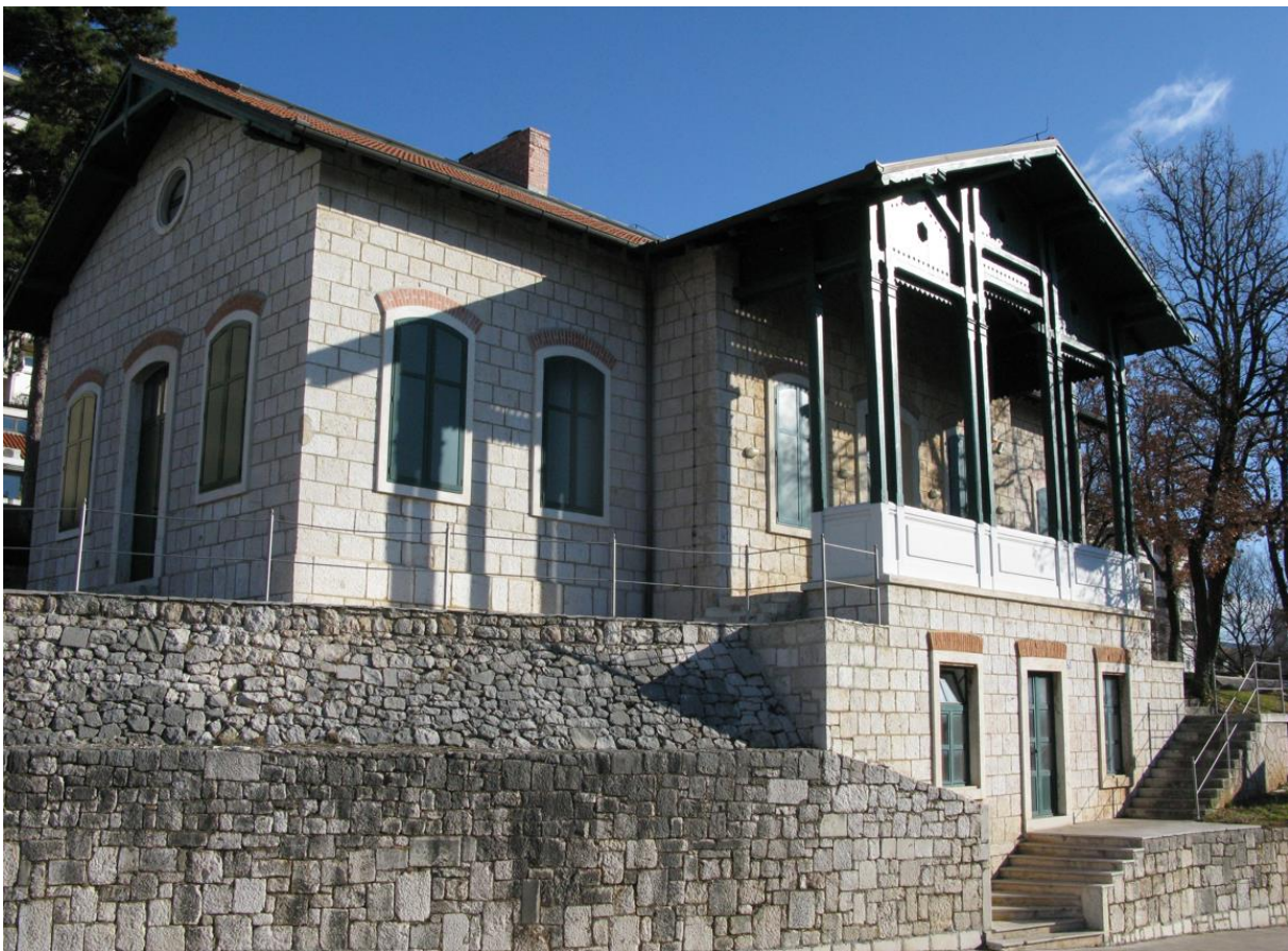
Slika 34. Nekadašnja zgrada Menze u kompleksu imotske Režije duhana, danas zgrada Zavičajnoga muzeja Imotske krajine.
