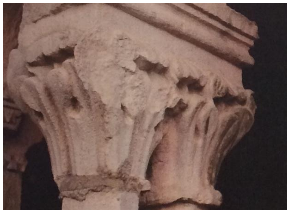
Slika 31. Oštećeni kapiteli
