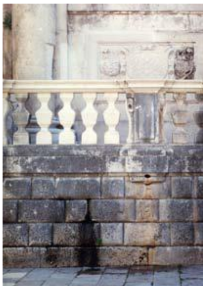
Slika 37. Obnovljena ograda i na crkvi sv. Vlaha
