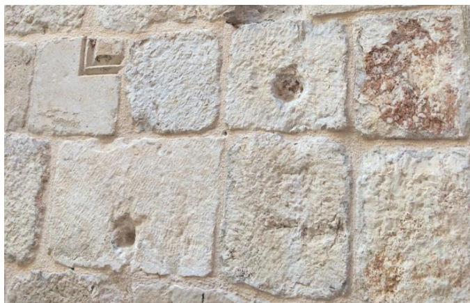
Slika 18. Površinske štete nastale pogotkom gelera
