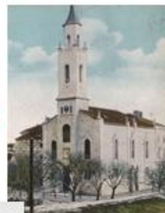
Crkva Sv. Petra na Lučcu, Gradnja: 1863.-1871. Porušena: 1944.
