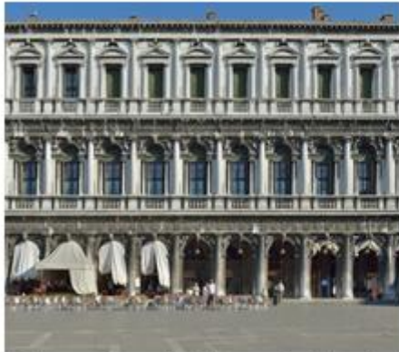
Nove prokurative (Procuratie Nuove), detalj fasade, Trg svetog Marka, Venecija, 1584.-1640.
