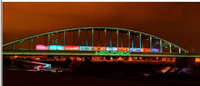
Željeznički Zeleni most, Zagreb, poslije obnove.
