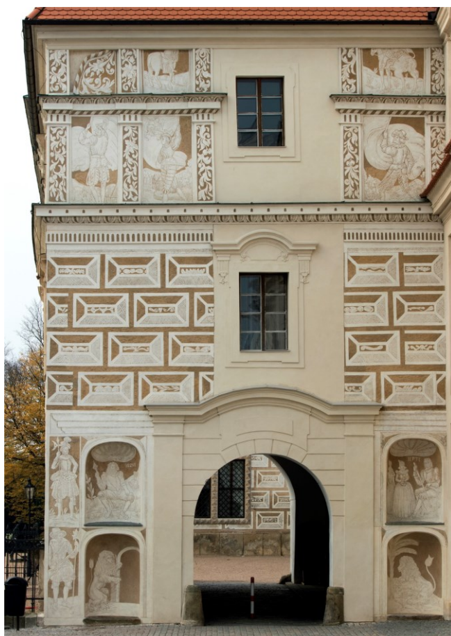
Slika 36. Jugoistočno pročelje ulaznog tornja pivovare
