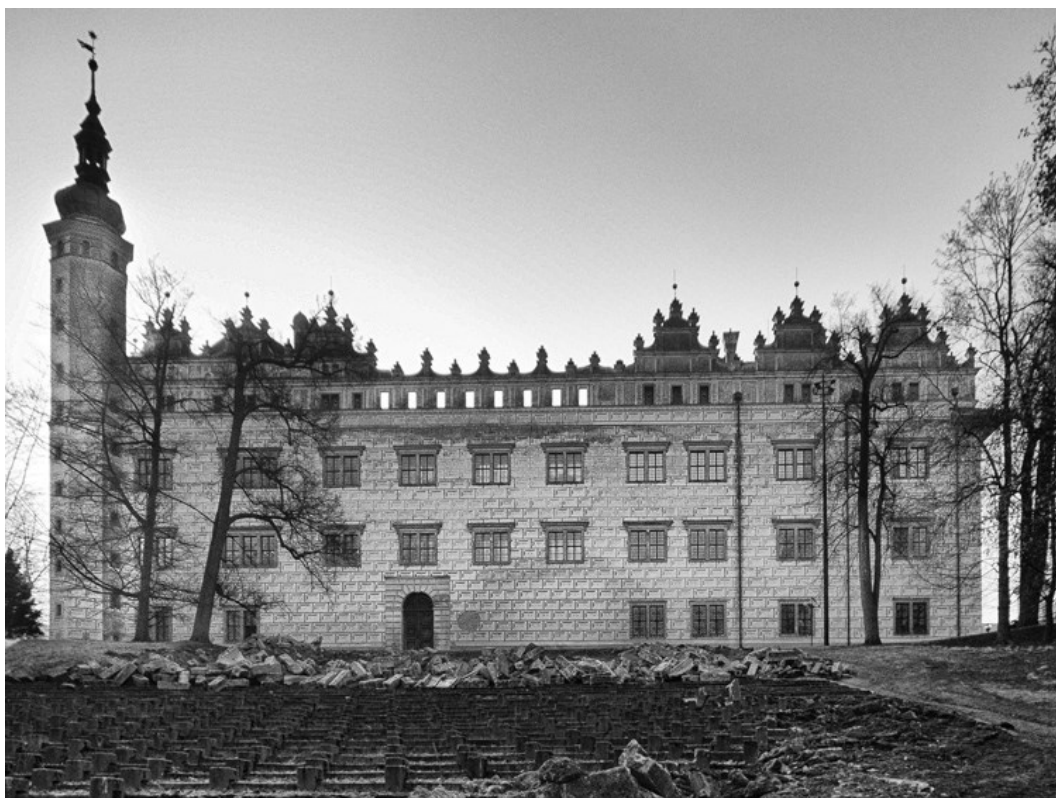
Slika 15. Sjeverno pročelje dvorca
