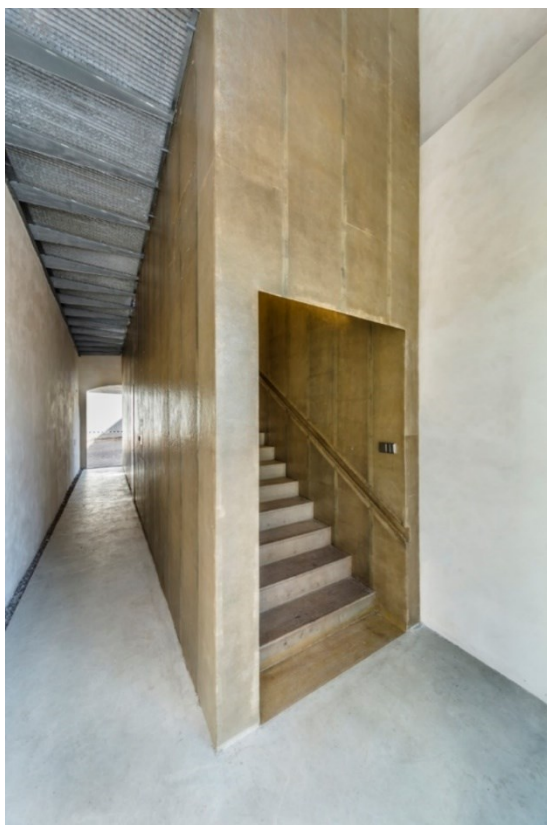
Slika 58. Kvadratna konstrukcija od stakloplastike u kojoj se nalazi jednokrako stubište
