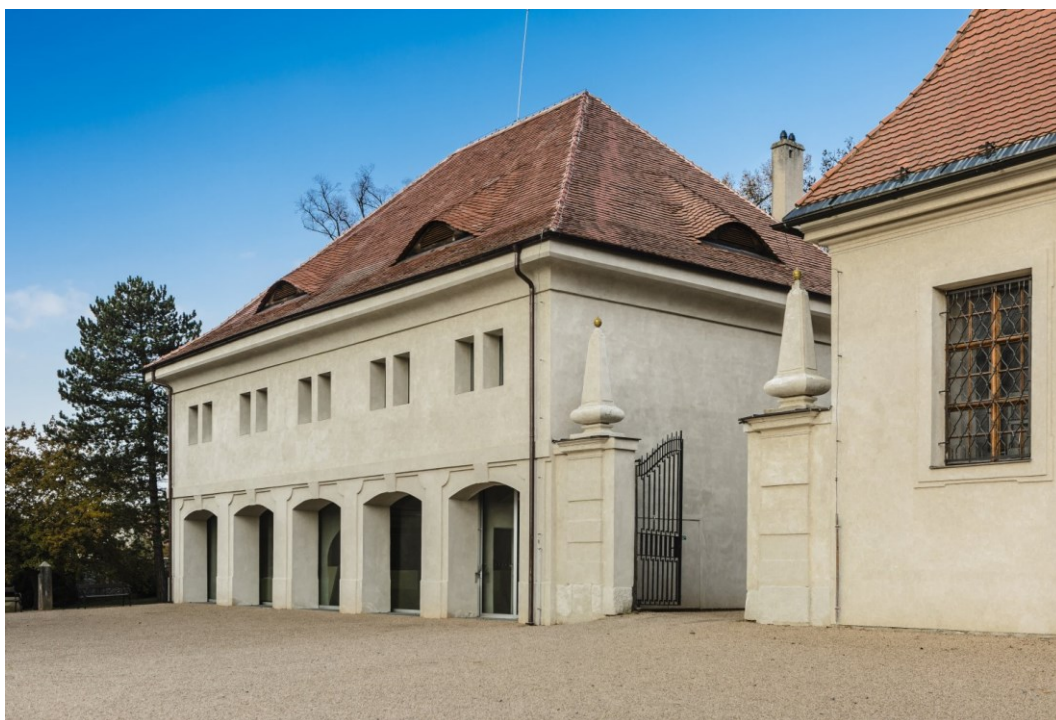
Slika 56. Spremište za kočije nakon projekta Revitalizace
