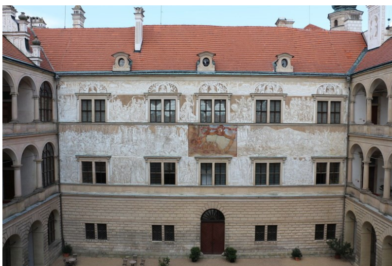
Slika 18. Sgrafito većeg unutarnjeg dvorišta
