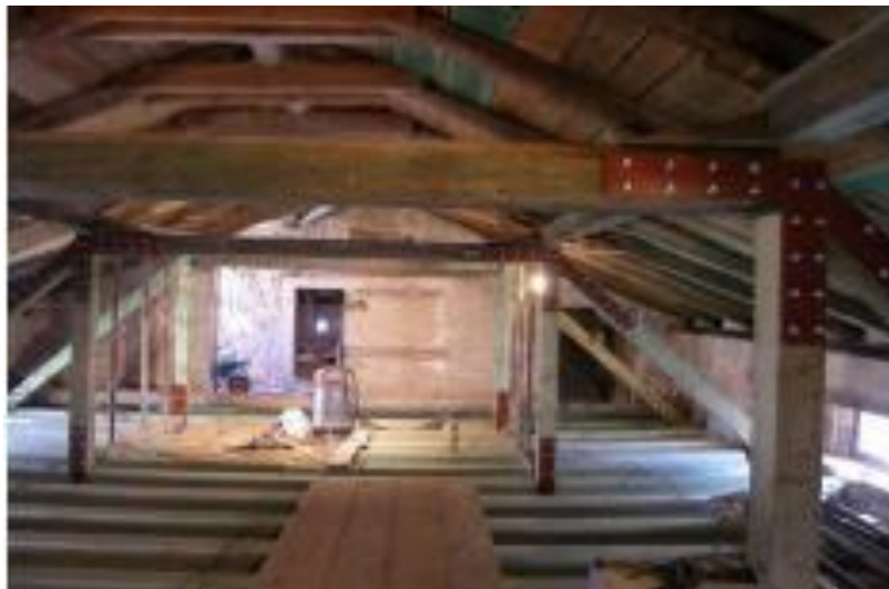
Slika 34. i 35. fotografije s restauracije krovišta zapadnog dijela kaštela, 2012. i 2013.
