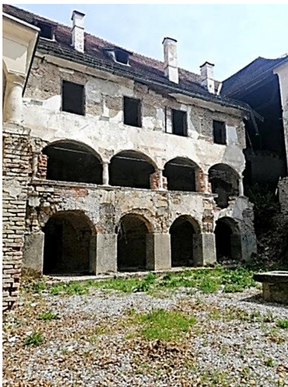
Slika 16. Arkadni trijemovi iz treće faze izgradnje, sjeveroistočno dvorišno pročelje
