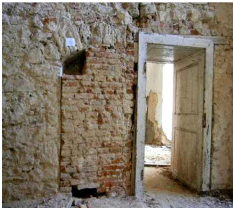
Slika 13. Zazidani vratni otvor iz druge faze izgradnje, prvi kat
