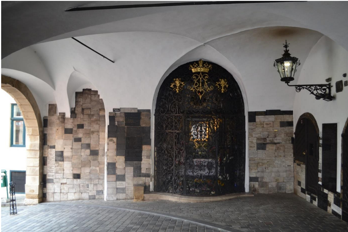
Slika 21. Unutrašnjost Kamenitih vrata nakon obnove 2018. godine, 2019., snimila: R.T.
