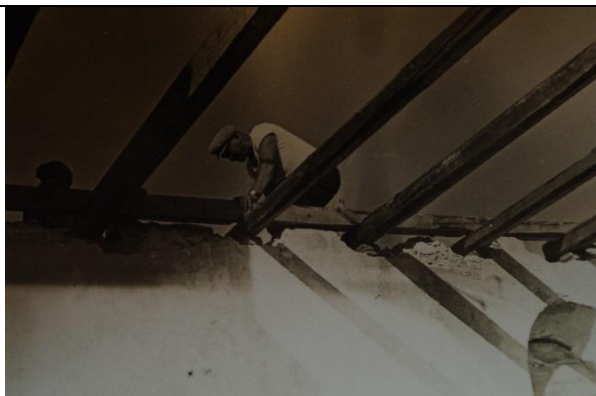
sl.27. Postavljanje krovišta
