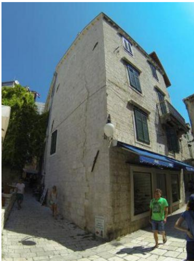
Slika 10. Stanje pročelja prije obnove
