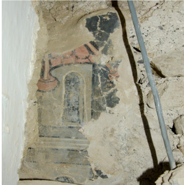
Slika 41: Otkriven fragment oslika sondiranjem na lijevom dijelu južnog zida drugog traveja
