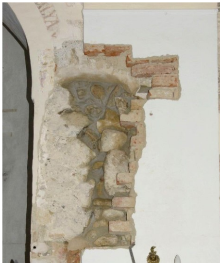
Slika 52: Niša nakon zapune novom građom
