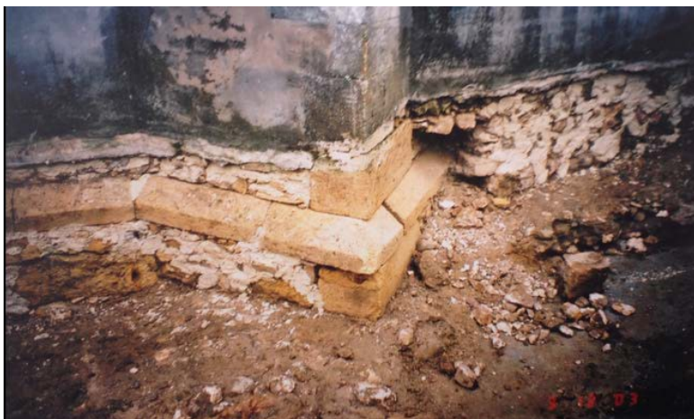
Slika 11: Dilatacija temelja lađe i svetišta vidljiva nakon iskopa jarka za drenažu, snimljeno u prosincu 2003. godine
