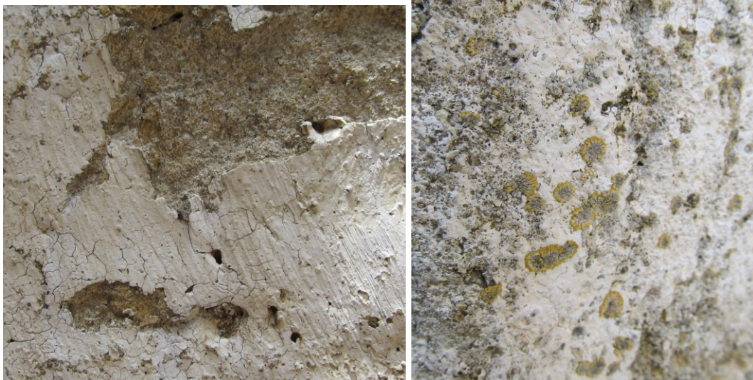
Slika 57 i 58: Središnji prozor, odvajanje bijelog naliča od podloge i mikroorganizmi na bijelom naliču
