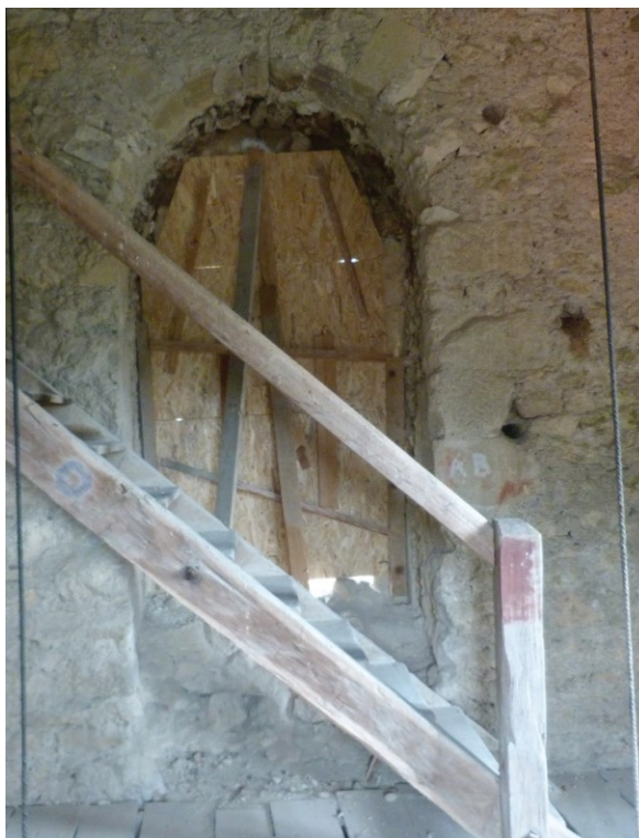
Slika 63: zatvaranje istočnog prozora zvonika OSB pločom
