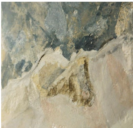
Slika 48: Obrub novom vapneno-pješčanom žbukom na rubovima izvornika na sjevernom zidu lađe
