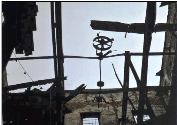
Sl. 45. I. Mucko i D. Novoselec, koloturnici u zgradi transmisije, Zagreb, 2019. godine
