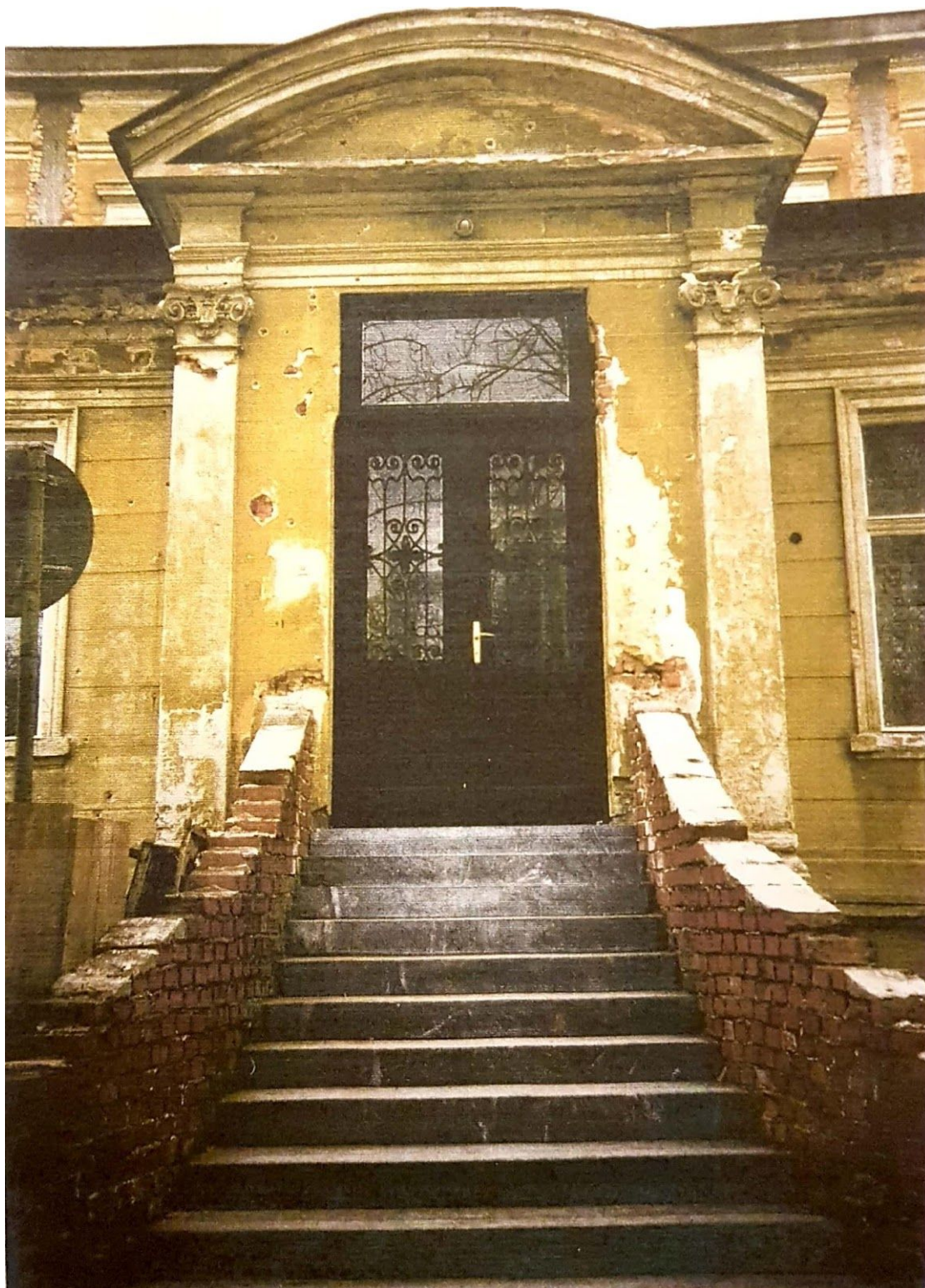
Prilog 16. - prikaz bočnih vrata sa zidićem, preuzeto iz: Davorin Stepinac, Marie Stepinac, Danijel Iveta: Karlovac - Zorin dom: obnova i prezentacija pročelja , Zagreb, 1998.
