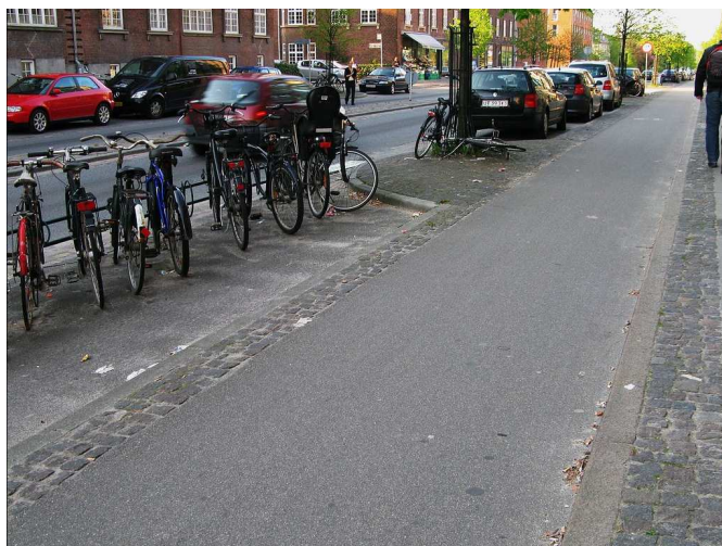
Slika 2. Biciklističke staze u stilu Kopenhagena gdje je staza zaštićena od motoriziranog prometa redom parkiranih automobila (Mikael Colville-Andersen, Copenhagenize, 5.1.2014)
