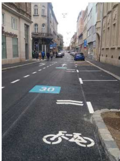
Slika 34. Nepropisno izvedene oznake za dijeljeni promet - Preradovićeva ulica (Sindikata biciklista, 15.8.2020)
