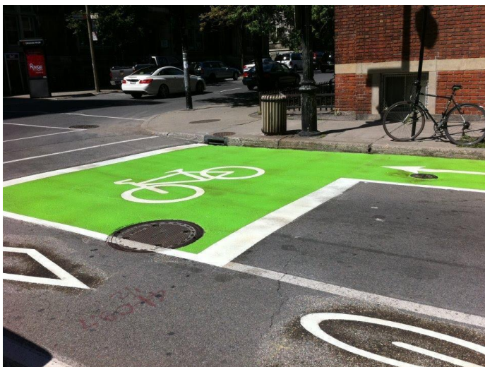
Slika 3. Prostor za zaustavljanje biciklista - "bike box" (Devin Alfaro, spacing.ca, 31.8.2011)
