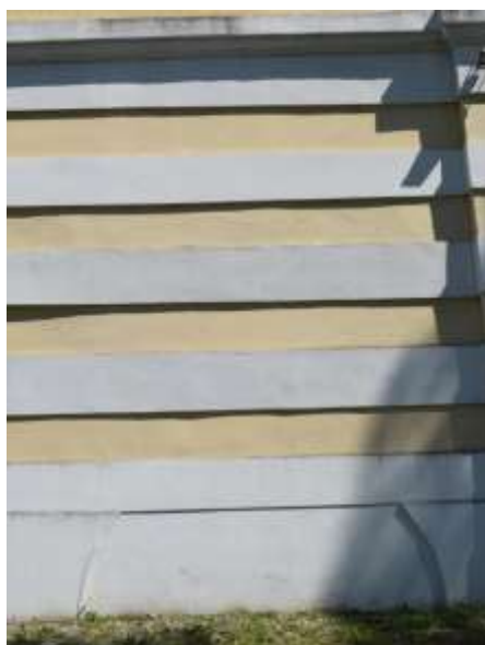
Slika 6. Glavna zgrada, dvorac Batthyány, ostatak nekadašnjeg portala dvorske kapele na zapadnom pročelju zgrade
