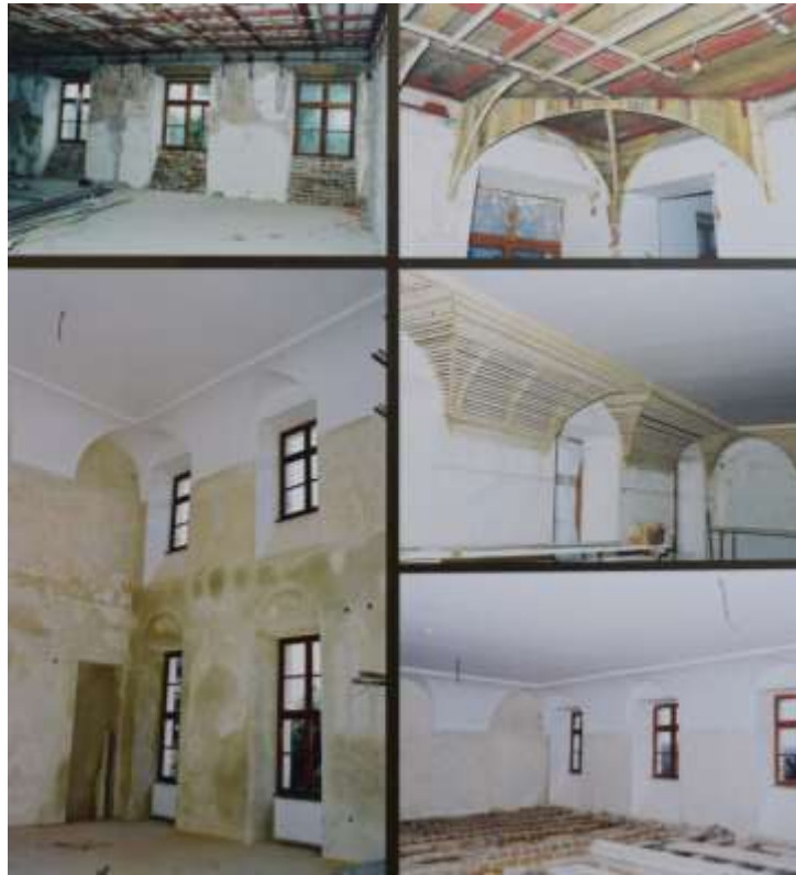
Slika 65. Glavna zgrada, dvorac Batthyány, građevinski radovi u prostoriji „Velike dvorane“ na prvom katu zapadnog krila zgrade, od 1997. do 2000. godine
