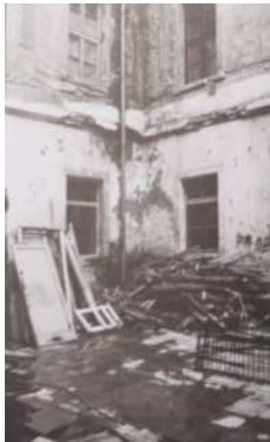
Slika 8. Glavna zgrada, dvorac Batthyány, zatečeno stanje dvorca 1991. godine, pogled na unutrašnje dvorište
