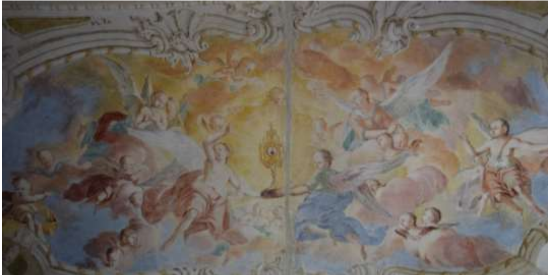
Slika 39. Glavna zgrada, dvorac Batthyány, zidni oslik na srednjem svodnom polju u brodu dvorske kapele
