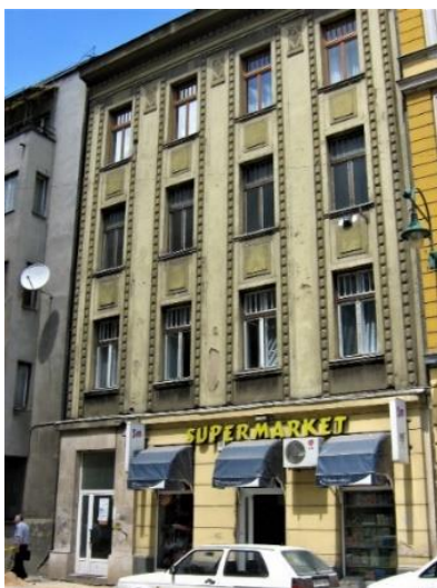
Slika br.185. Stambena zgrada Jove Odovića, 1911. (?)
