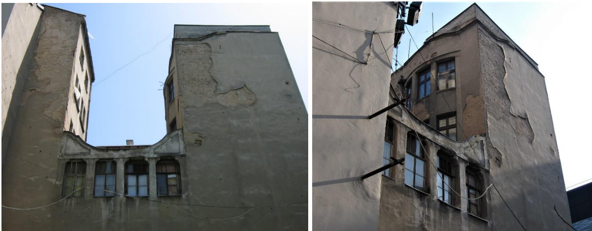
Slika br.104 i 105. Detalj kubusa koji spaja ulični i dvorišni dio zgrade, 2015.
