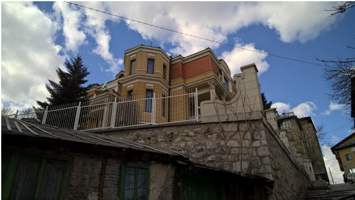
Slika br.88. Zgrada Sunarić, južna strana, 2015.
