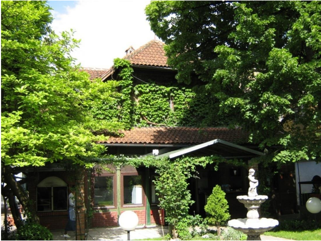
Slika br.27. Zgrada Miklau, unutrašnje dvorište, 2014.
