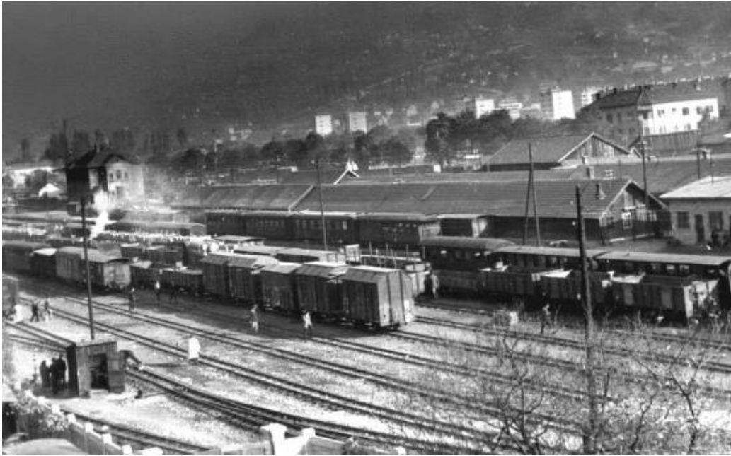
Slika br.71. Željeznička stanica sa radionicama u Sarajevu, stanje 1960.
