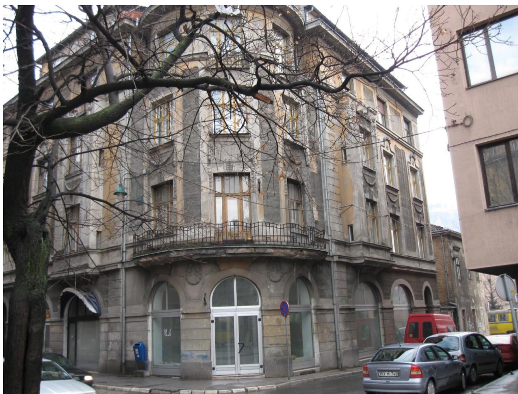
Slika br.92. Najamna trgovačko – poslovna i stambena zgrada Mordohaja Atijasa, 2015.
