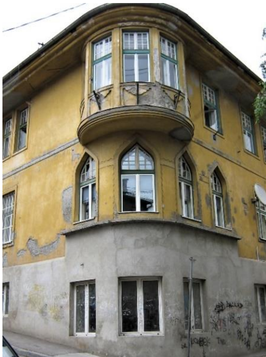
Slika br.175. Stambena zgrada Nurudin-bega Azapagića, 2014.
