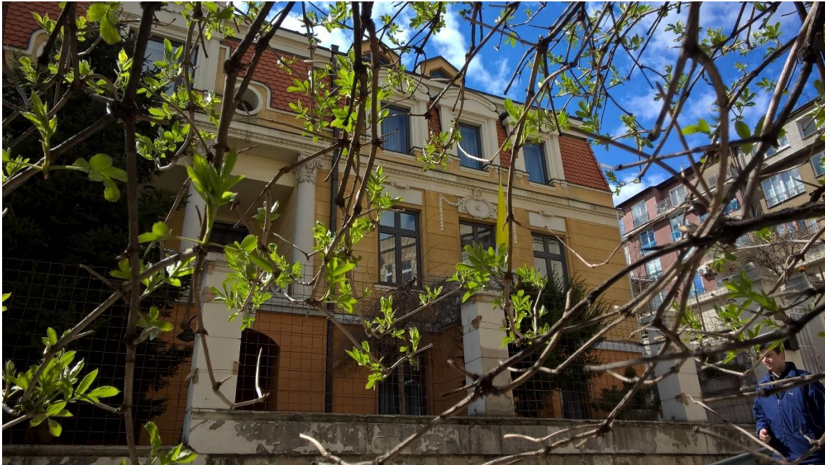
Slika br.89. Zgrada Sunarić, istočna strana, 2015.
