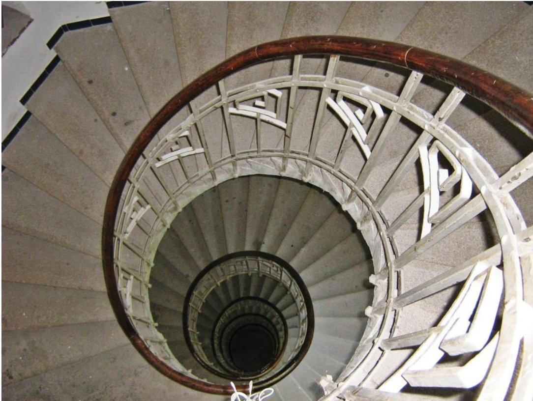
Slika br.109. Detalj stubišta, 2015.
