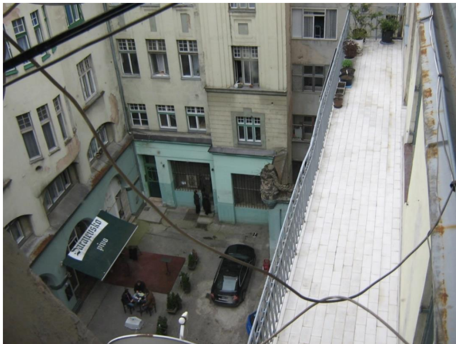
Slika br.150. Pogled na atrij sa zapadne strane dvorišne fasade, 2014.
