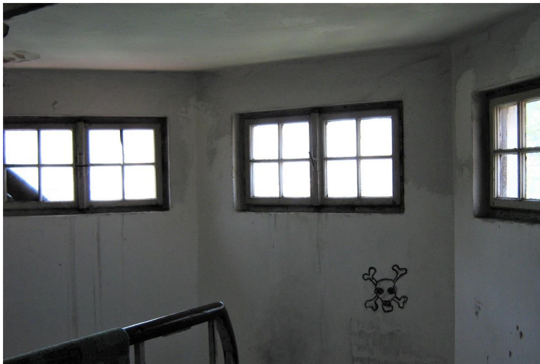
Slika br.110. Detalj stubišta mansarde, 2015.
