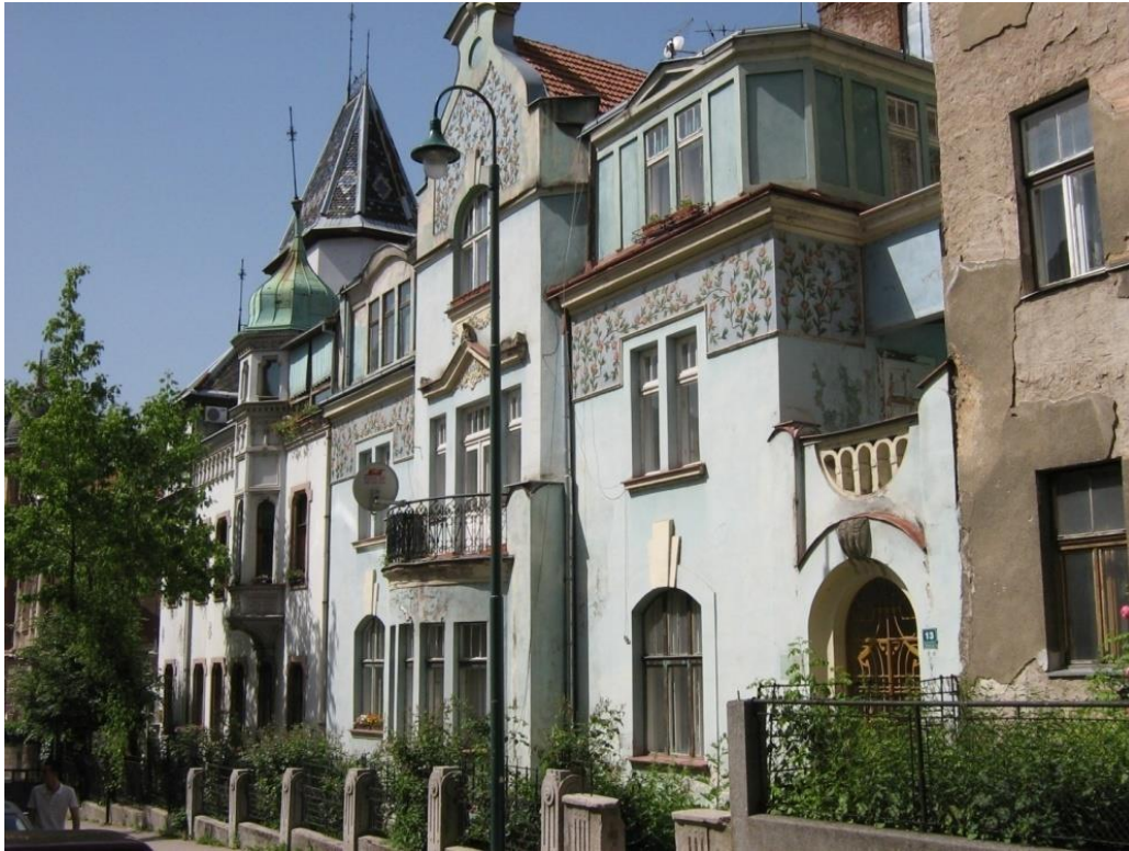
Slika br.35. Zgrada Rädisch, 2013.
