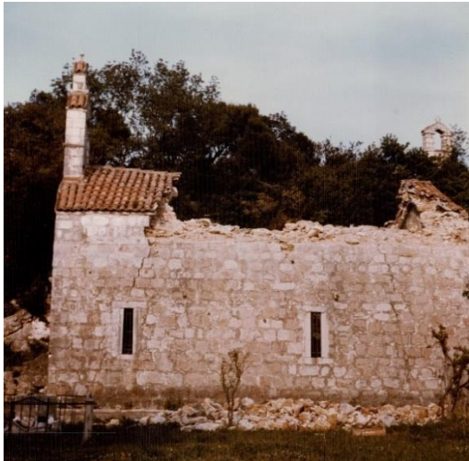
Sl. 154. Izgled crkve Svetog Nikole u Gradištu nakon razornog potresa, foto: Uprava za zaštitu kulturnih dobara, Cetinje
