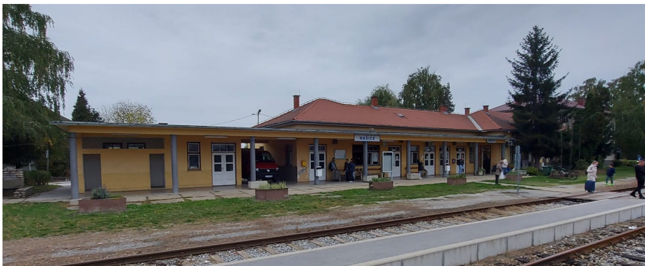
Slika 51. Novi željeznički kolodvor izgrađen nakon Drugog svjetskog rata
