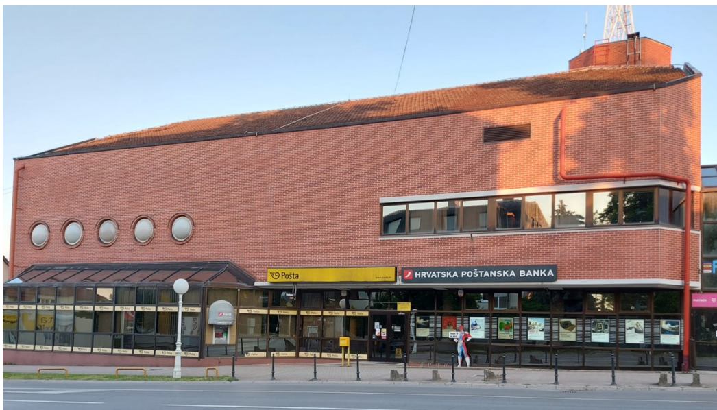
Slika 154. Nova pošta, glavno pročelje
