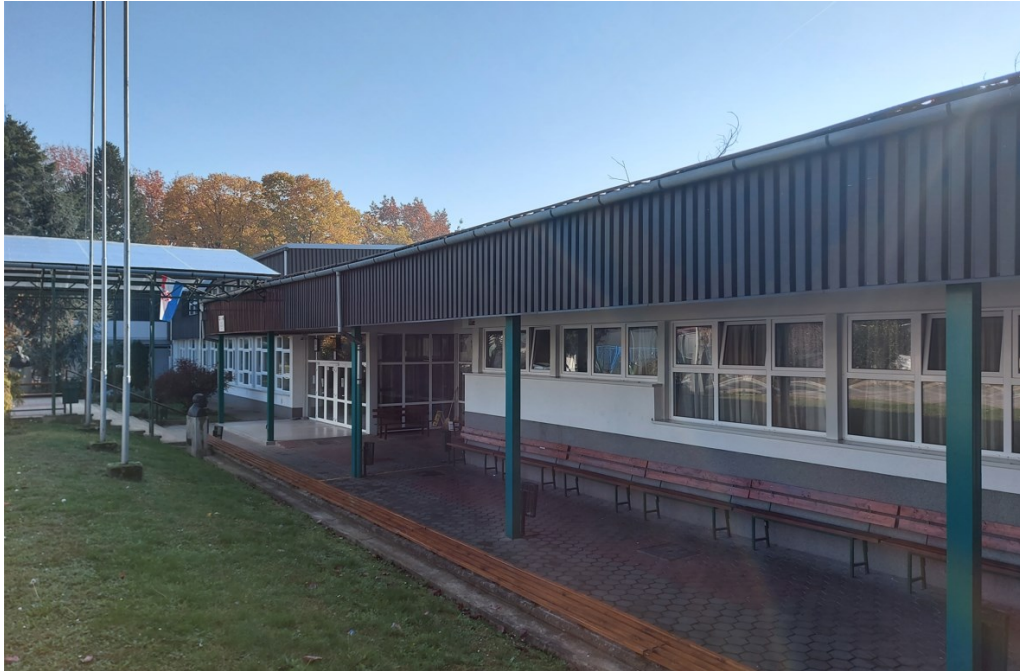
Slika 145. Pogled na sjeverno pročelje srednje škole
