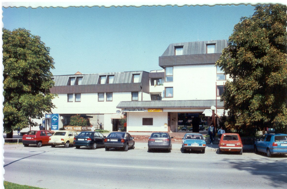
Slika 152. Glavno (južno) pročelje hotela
