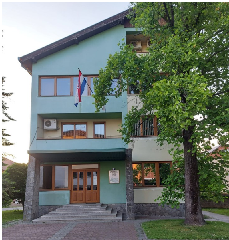
Slika 129. Glavno (južno) pročelje šumarije - današnji izgled
