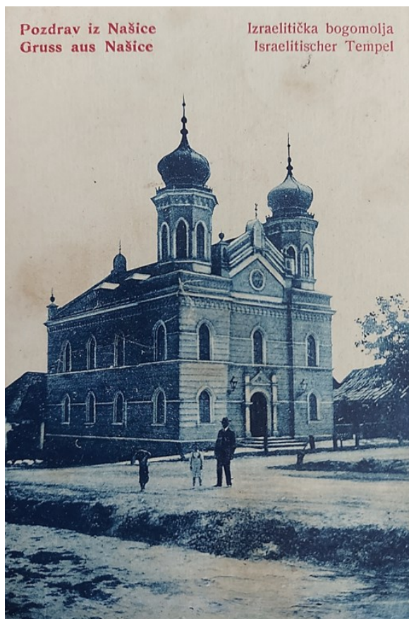
Slika 38. Pogled na glavno pročelje sinagoge
