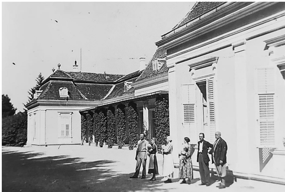
Slika 85. Južno pročelje malog dvorca
