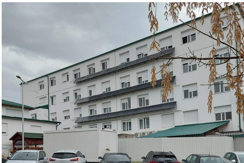
Slika 143. Pogled na zapadno krilo bolnice
