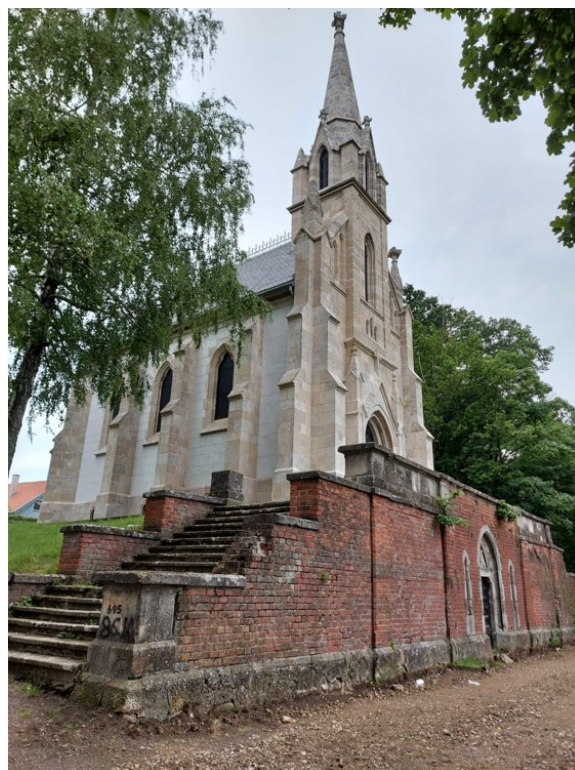
Slika 33. Pogled na glavno i bočno pročelje - današnji izgled
