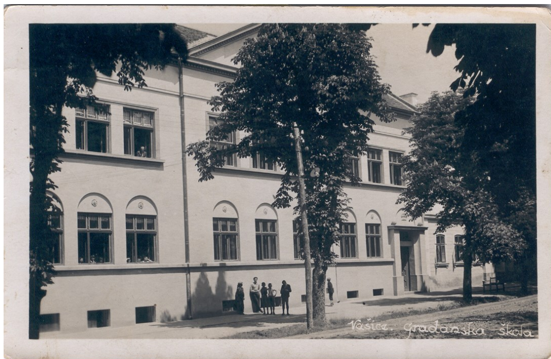
Slika 93. Glavno pročelje Građanske škole
