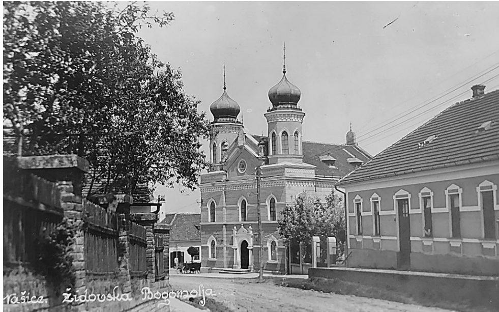
Slika 39. Pogled na glavno pročelje sinagoge i zgradu rabinata iz Ulice Vatroslava Lisinskog
