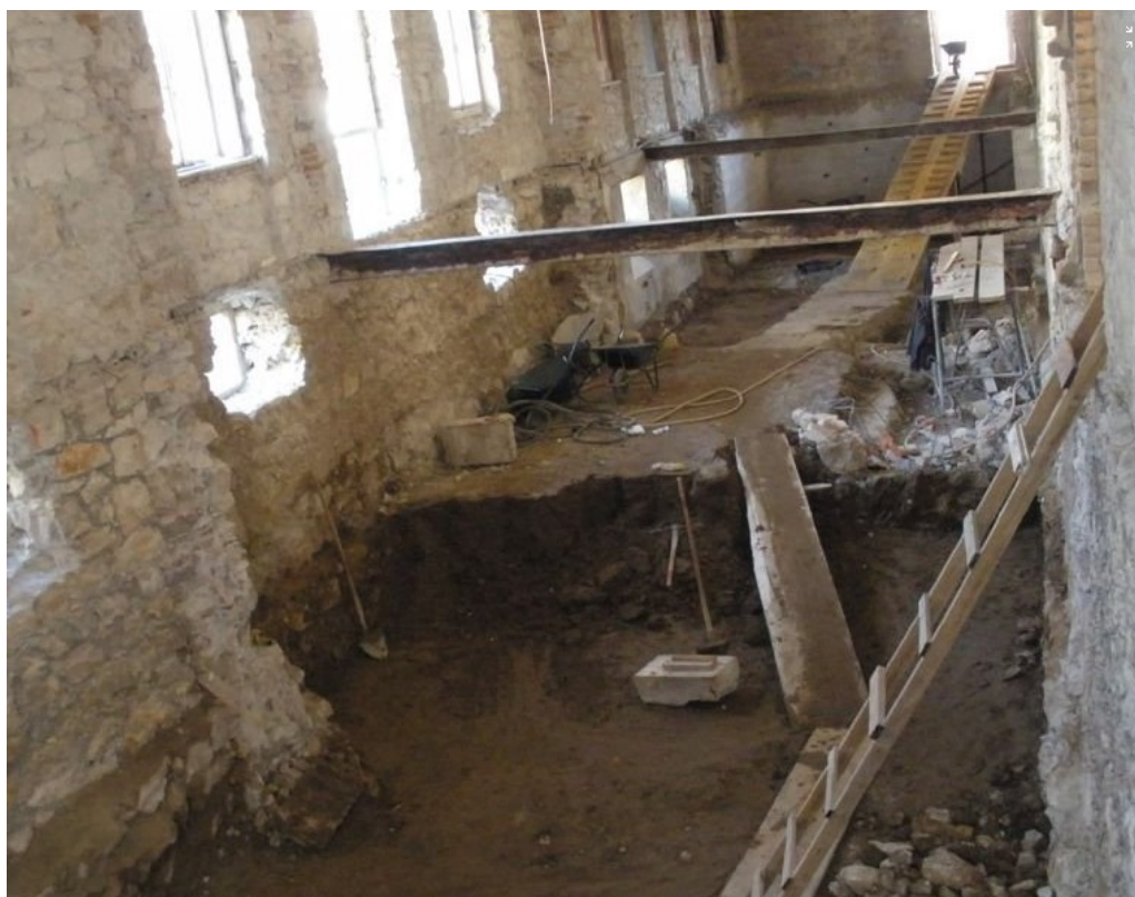
sl. 112. Prostor dijela budućeg suterena bivše zgrade uprave i stanovanja i stanovanja duhanske stanice u Metkoviću, danas Prirodoslovnog muzeja i Gradske knjižnice, snimljen u procesu iskopavanja. Fotografirano tijekom obnove zgrade koja je trajala od 2008. do 2015. godine
