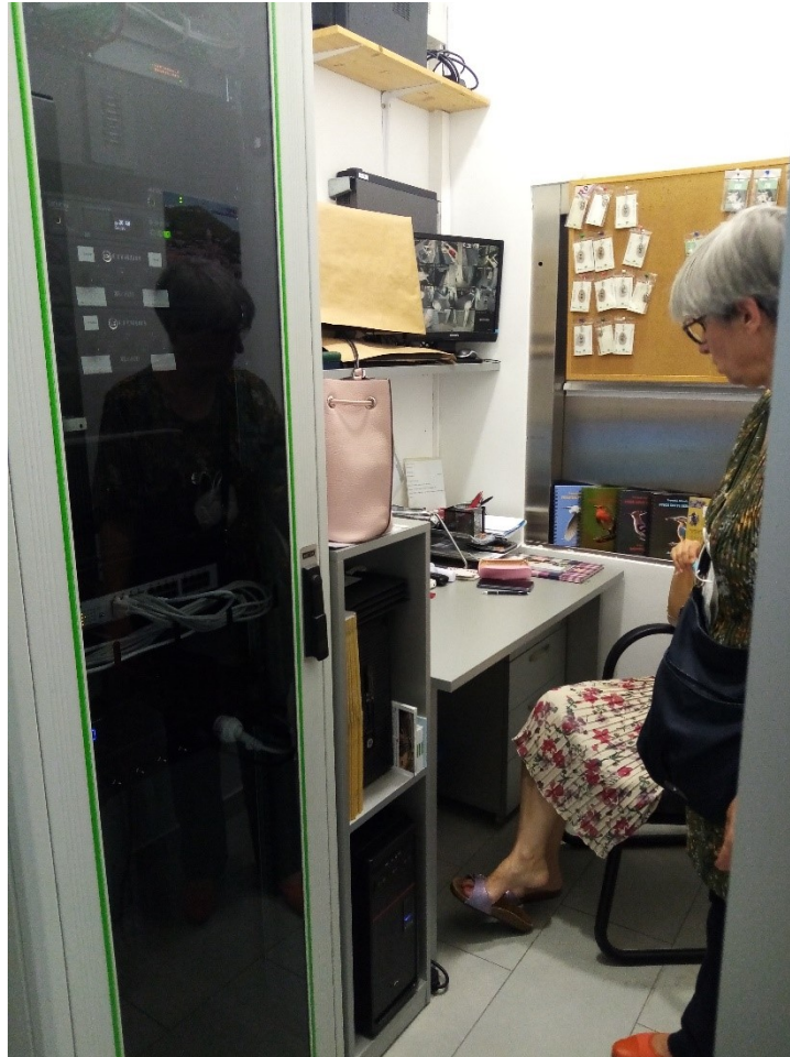
sl. 119. Prostor iz kojega se vrši nadzor zgrade i okolice Prirodoslovnog muzeja u Metkoviću, opremljen monitorom. Zbog nedostatka prostora, koristi se i kao prostor za tehniku i energiju, gdje se čuvaju multimedijalni stupovi, te suvenirnica
