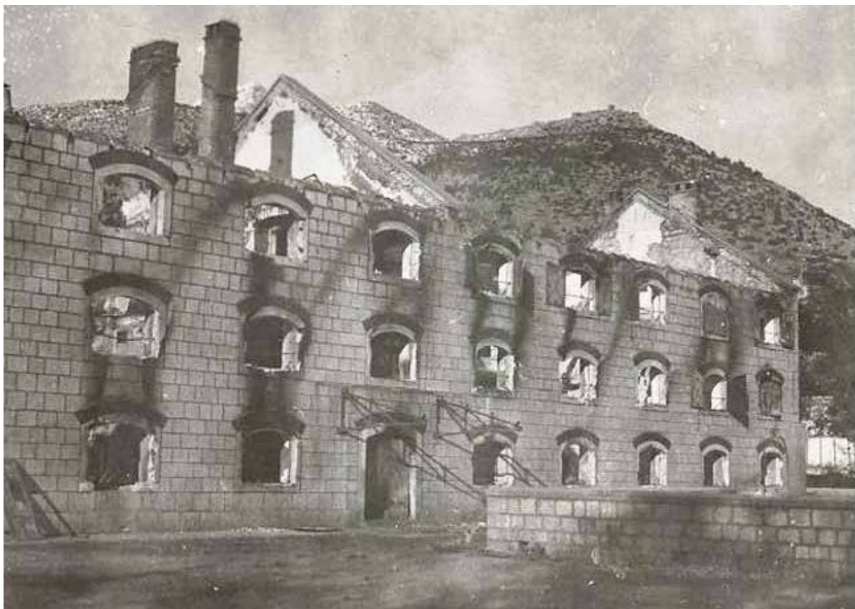
sl. 3. Požarom oštećena skladišna zgrada bivše duhanske stanice u Vrgorcu. Snimljeno sredinom 20. stoljeća, tj. u vrijeme ili neposredno nakon Drugog svjetskog rata
