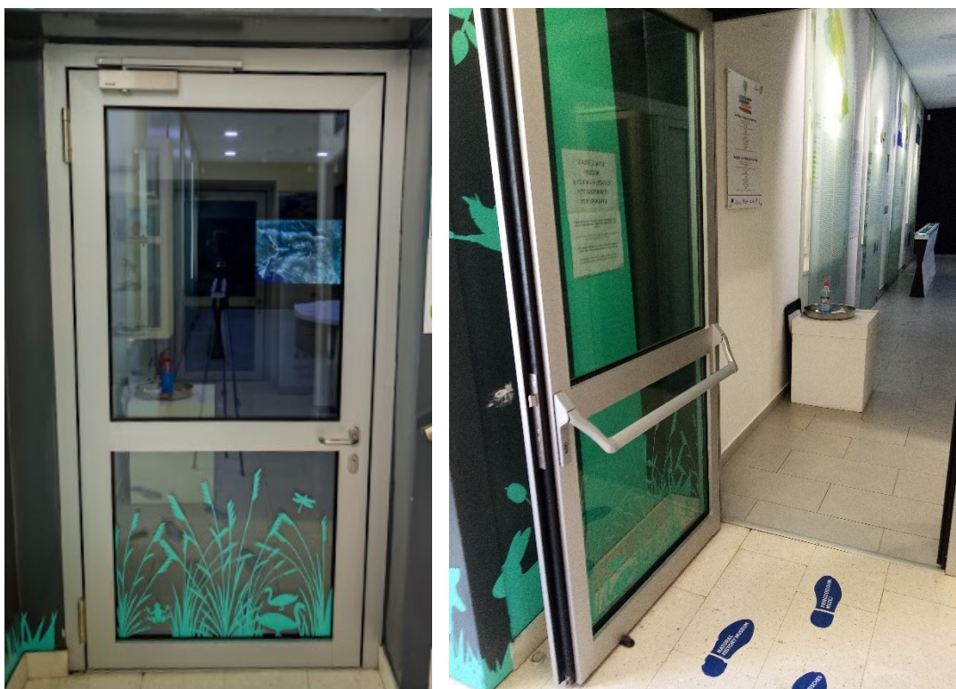
sl. 121. (lijevo) Zatvorena jednokrilna vrata ulaza kroz koja se iz ulaznog predvorja ulazi u izložbeni prostor Prirodoslovnog muzeja u Metkoviću. Ista su vrata postavljena i na ulazima u prostore Gradske knjižnice na katovima; (desno) Otvorena vrata ulaza kroz koja se iz ulaznog predvorja ulazi u izložbeni prostor
