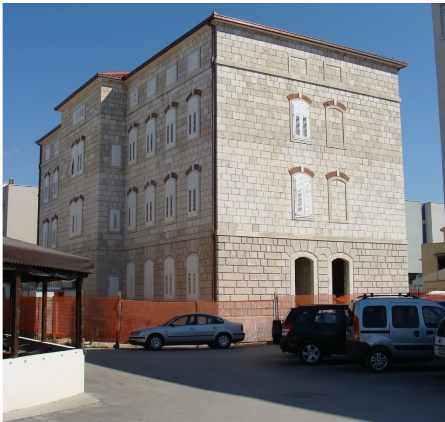
sl. 108. Pogled na južno i zapadno pročelje bivše zgrade uprave i stanovanja duhanske stanice u Metkoviću, danas Prirodoslovnog muzeja i Gradske knjižnice. Fotografirano pri kraju obnove koja je trajala od 2008. do 2015.
