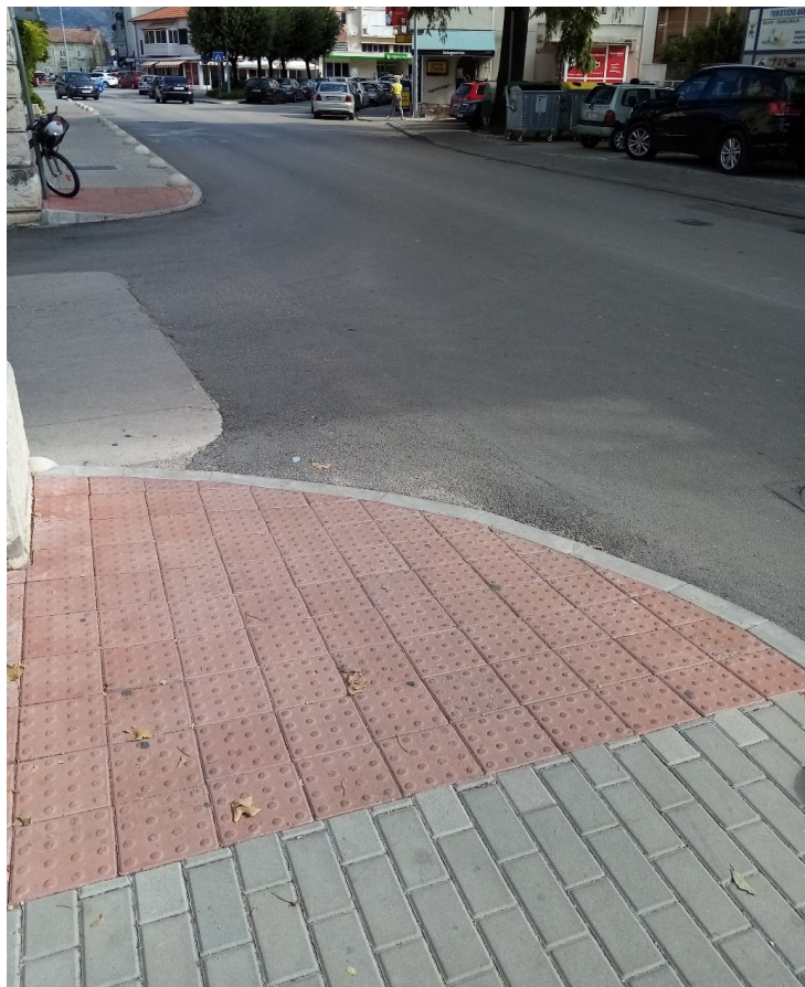
sl. 74. Sniženi te drugačijom teksturom i bojom označeni rubovi nogostupa u Ulici kralja Zvonimira u Metkoviću, prilagođeni slijepim i slabovidnim osobama. Snimljeno ispred istočnog pročelja bivše zgrade uprave i stanovanja duhanske stanice u Metkoviću, danas Prirodoslovnog muzeja i Gradske knjižnice
