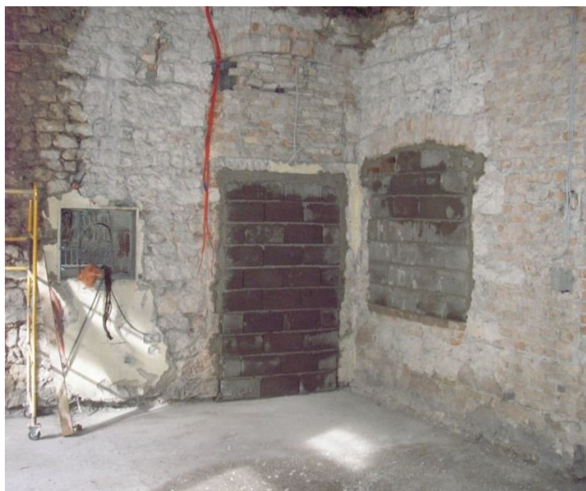
sl. 114. Zazidani otvori zidova u prizemlju bivše zgrade uprave i stanovanja i stanovanja duhanske stanice u Metkoviću, danas Prirodoslovnog muzeja i Gradske knjižnice. Fotografirano tijekom obnove zgrade koja je trajala od 2008. do 2015. godine
