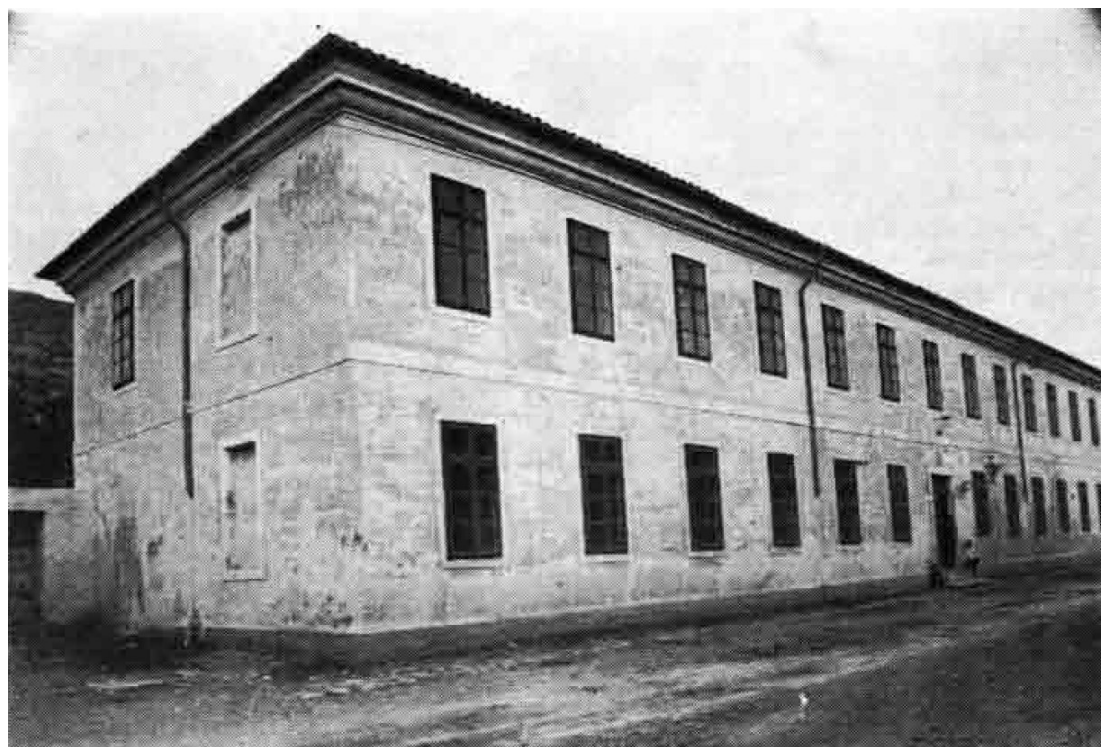
sl. 14. Zgrada izvorno izgrađena kao artiljerijska vojarna u Senju, koja je 1896. prenamijenjena u tvornicu duhana
