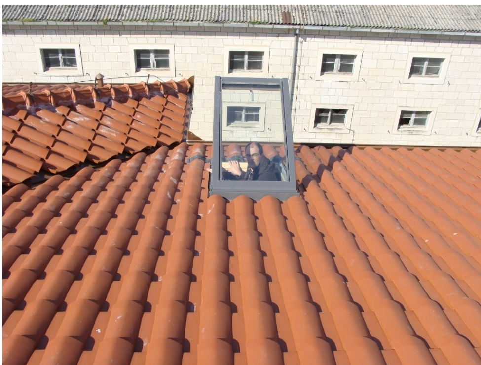
sl. 106. Novi krovni pokrov krova bivše zgrade uprave i stanovanja duhanske stanice u Metkoviću, danas Prirodoslovnog muzeja i Gradske knjižnice, koji imitira kupe kanalice. Fotografirano pri kraju ili nedugo nakon završetka obnove koja je trajala od 2008. do 2015. godine. Vidljiv je i jedan od novih krovnih prozora, a u pozadini i gornji dio susjedne zgrade najstarijeg kamenog skladišta, s azbestnim krovom
