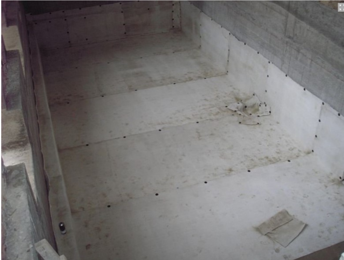
sl. 135. Zaštitni sloj hidroizolacije postavljen na donjem unutrašnjem dijelu suterena bivše zgrade uprave i stanovanja duhanske stanice u Metkoviću, danas Prirodoslovnog muzeja i Gradske knjižnice. Fotografirano tijekom obnove zgrade koja je trajala od 2008. do 2015. godine
