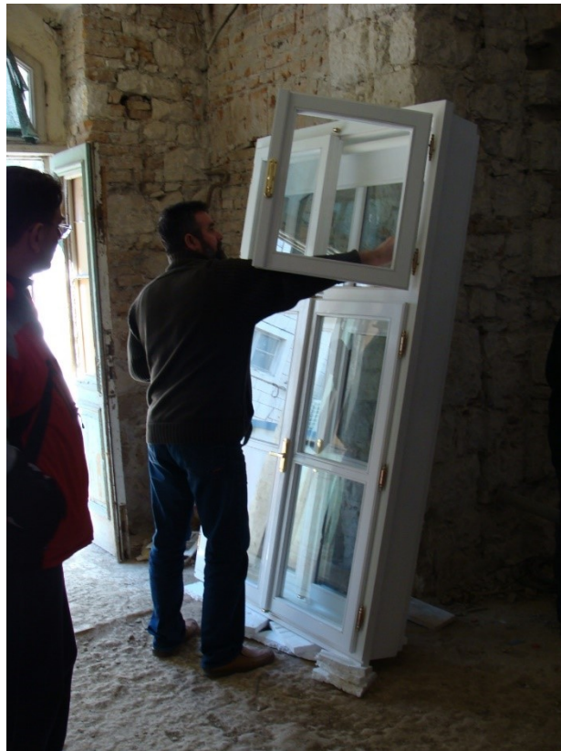
sl. 88. Novi dvostruki prozori napravljeni za bivšu zgradu uprave i stanovanja duhanske stanice u Metkoviću, danas Prirodoslovnog muzeja i Gradske knjižnice, koji kopiraju stare
