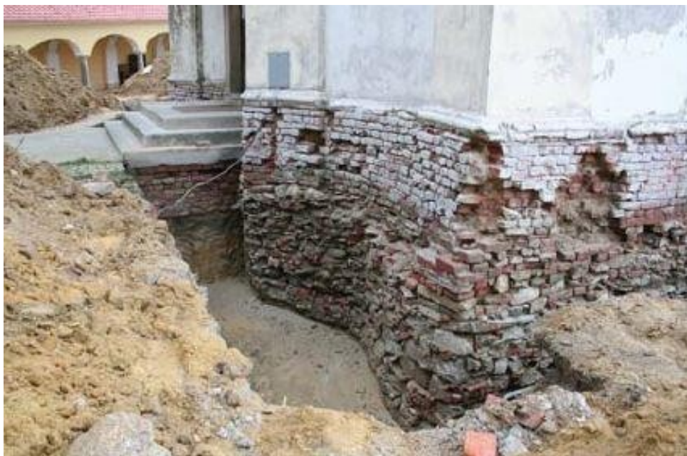
Slika 59. Hidroizolacijski radovi prije urušavanja
