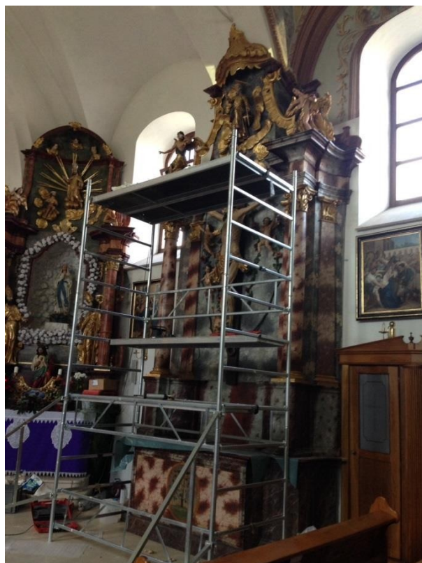
Slika 90. Proces montiranja oltara na izvornu poziciju pri kraju radova (snimljeno 2014.)
