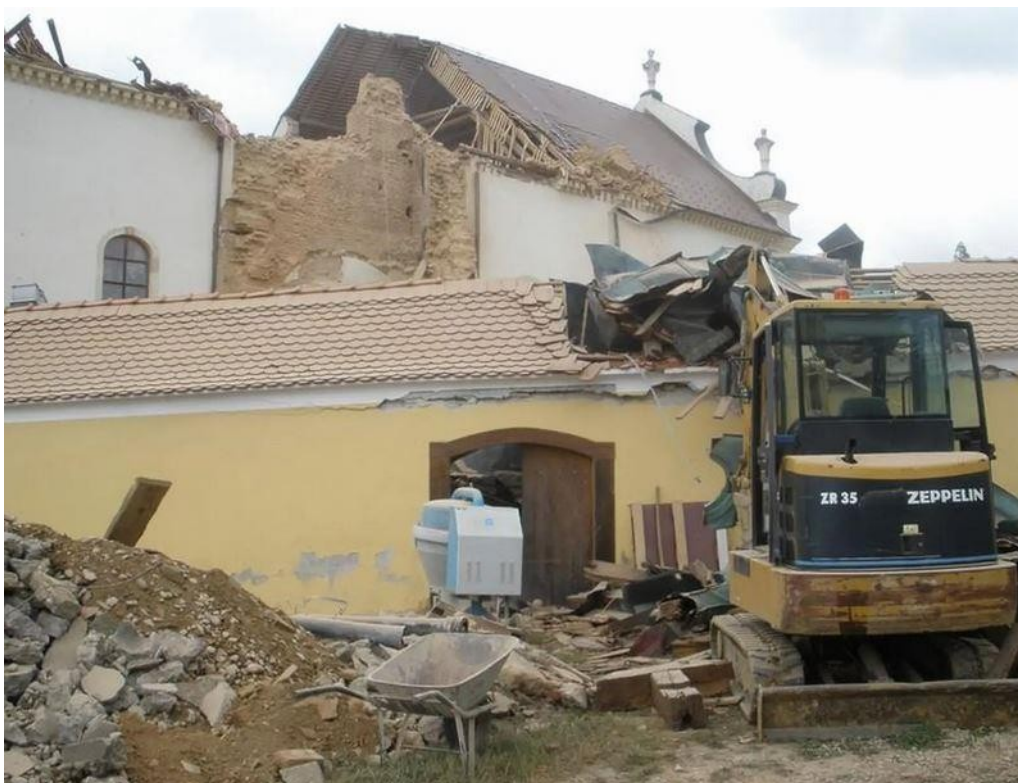
Slika 70. Oštećenje na cinktoru (snimljeno 2008.)
