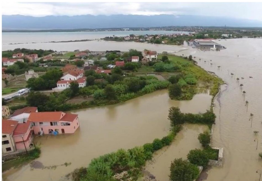
Slika 27 Poplavljeni stambeni objekti, solana i poslovni objekti u Ninu, 11. rujan 2017. godine
