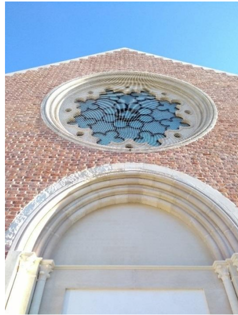
Slika 13. Detalj zapadnog pročelja crkve Sv. Marije Magdalene u Čazmi nakon restauratorskih radova
