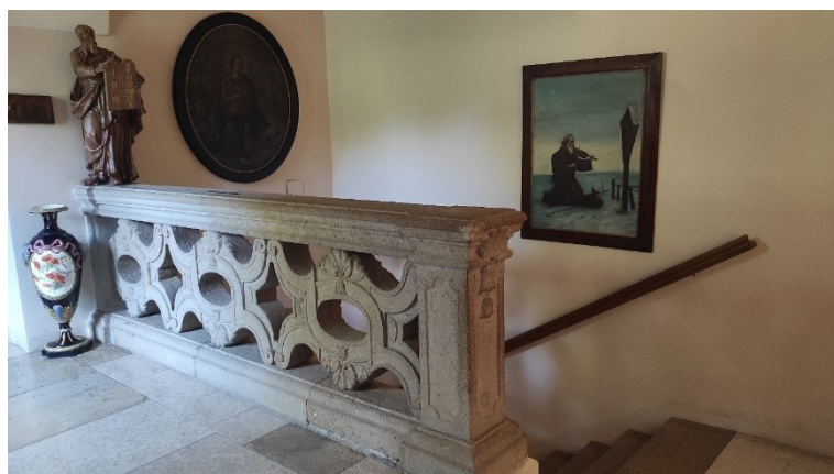
Slika 53 – Kamena ograda stubišta, prvi kat, dvorac Lužnica
