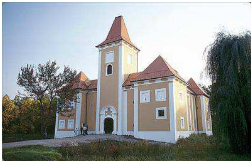
Slika 10. Bočna strana nakon restauracije
