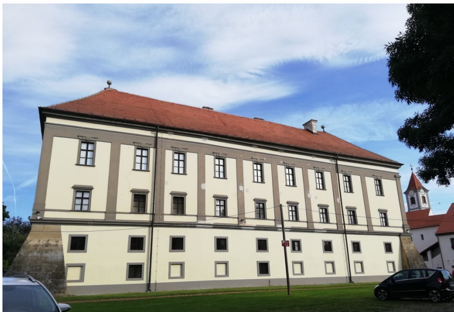
Slika 10: Jugoistočno pročelje, pogled s juga
