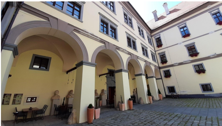
Slika 13: Dvorišno pročelje jugoistočnog krila
