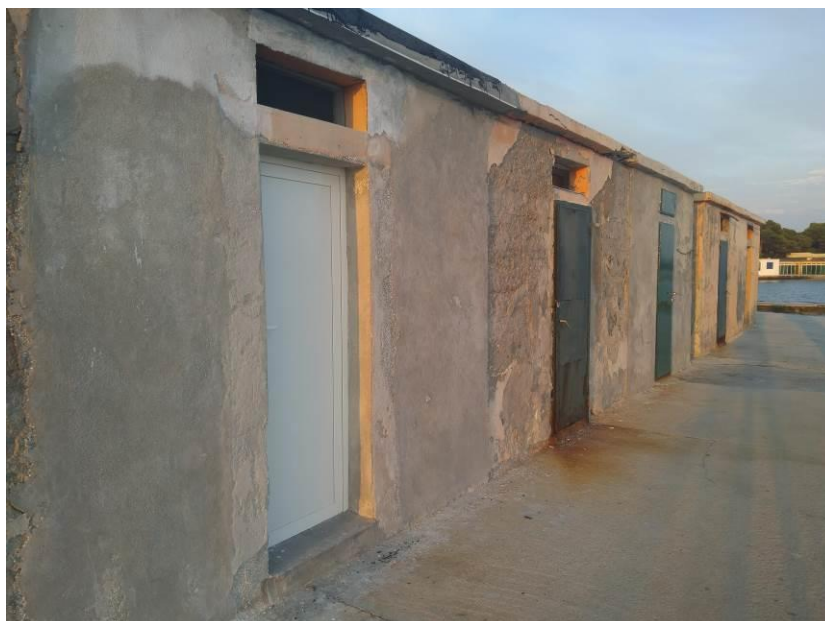
Prilog 8. Fotografija kabina iz treće faze, građenih između 1936. i 1938. godine. Primjetna je razlika u veličini u odnosu na kabine-presvlačione koje se vide u pozadini desno. Također su vidljive izmjene na pojedinim kabinama, ožbukavanje i mijenjanje ulaznih vrata. Fotografirala Martina Šoda u svibnju 2018.
