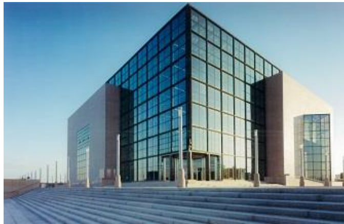
Slika 8. Zgrada današnje Nacionalne i sveučilišne knjižnice
