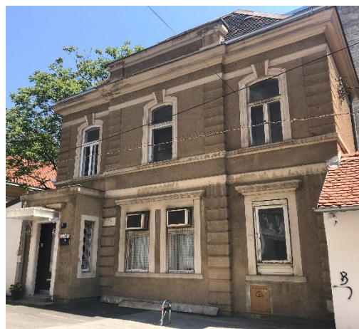
Sl. 41. Glavno pročelje nekadašnjeg Mosingerovog foto-atelijera u dvorištu Ilice br. 8.; fotografirano 3. lipnja 2021. (M. Šafarić)
