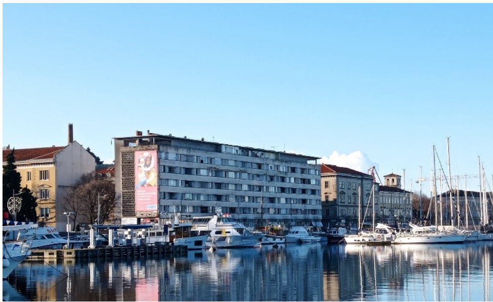
Slika 35. Vizura rive i ulično pročelje
