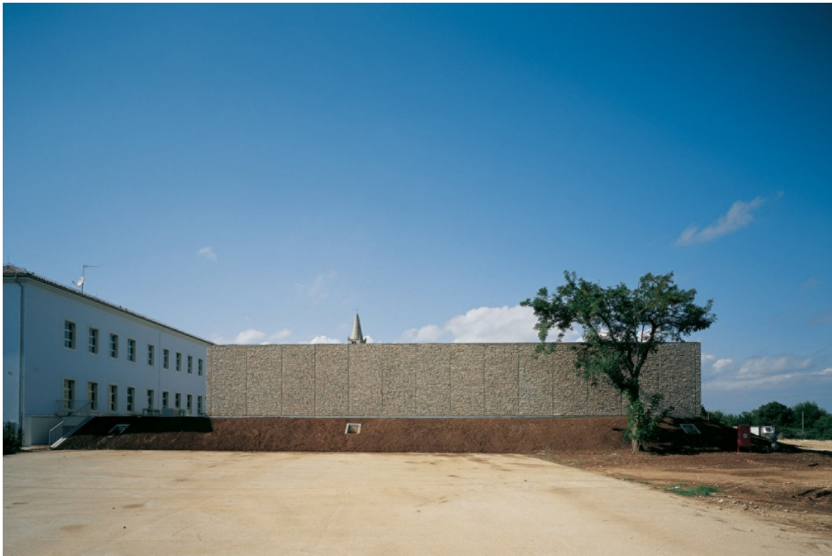
Slika 169. Južno pročelje sportske dvorane Bale
