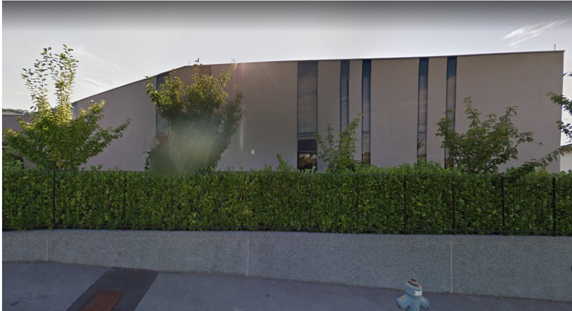
Slika 66. Pogled s ulice Dedići na Kuću V
