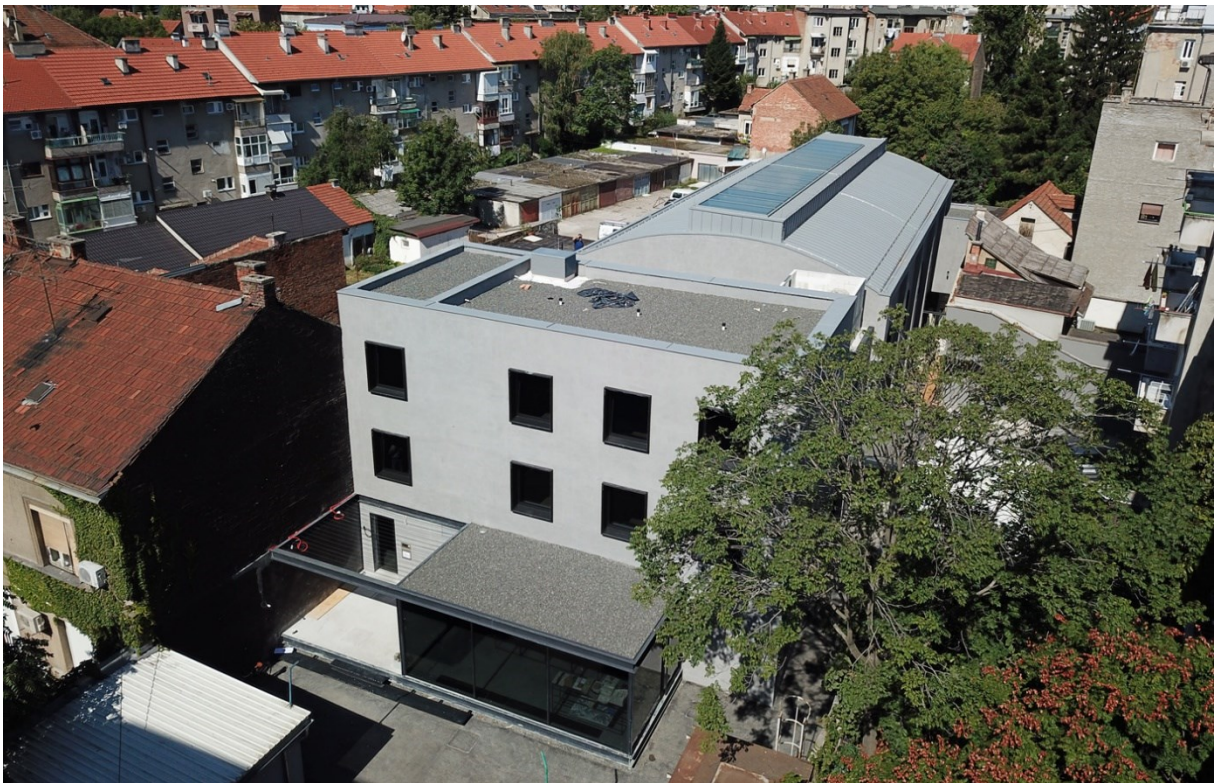
Slika 147. Glavno pročelje nekadašnjeg kina Urania, pregrađenog prema projektu 3LHD-a
