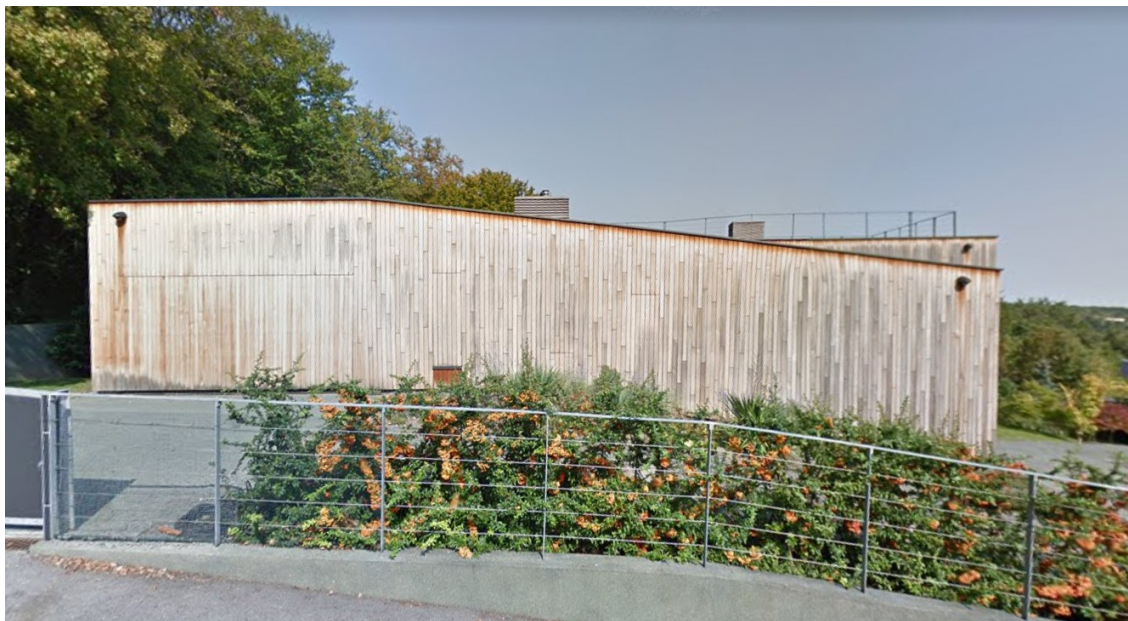
Slika 63. Jugoistočno ulično pročelje Kuće K
