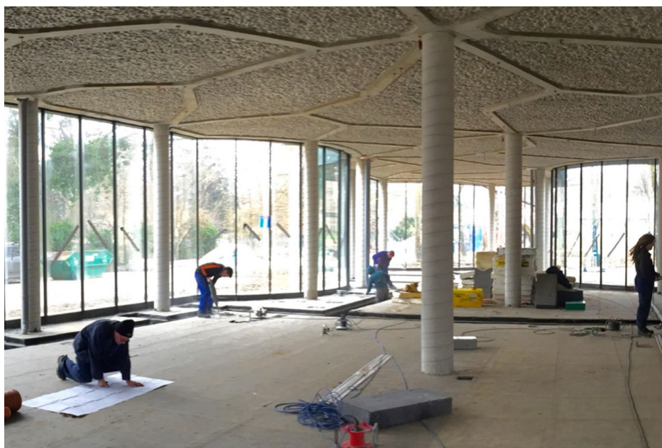
Slika 103. Zapadni dio Zelenog paviljona tijekom izgradnje
