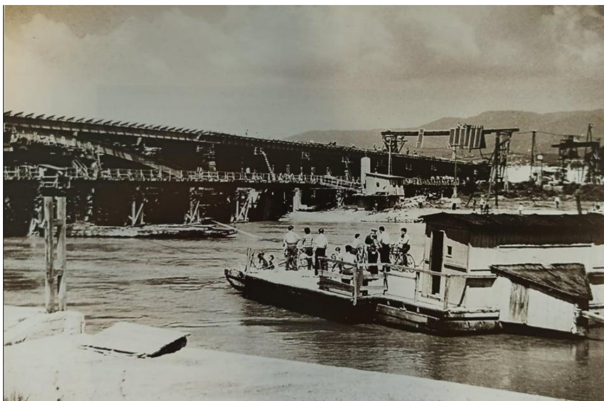
SLIKA 9. MOST SLOBODE U IZGRADNJI, 1959. GODINA (Povijest grada Zagreba, 158.)
