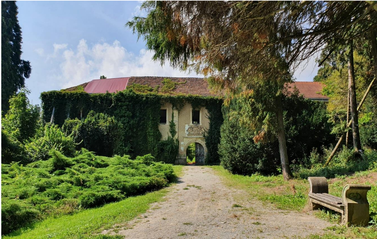
Slika 10. Sjeverno pročelje sjevernog krila s portalom (fotografirala Emilija Gregurec, 13. kolovoza 2020.)
