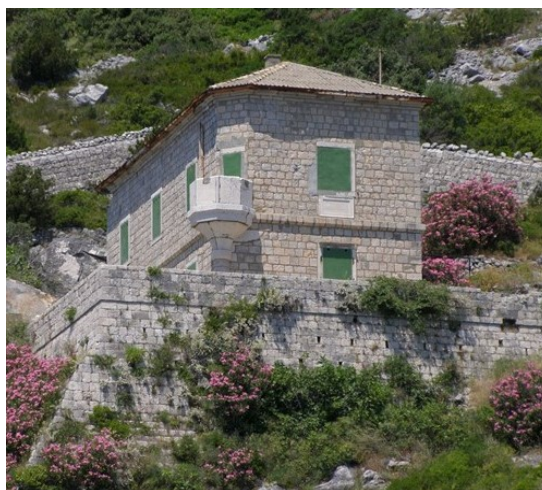
Slika 43 Zgrada za smještaj svjetioničara i prvotni svjetionik na otočiću Olipa
