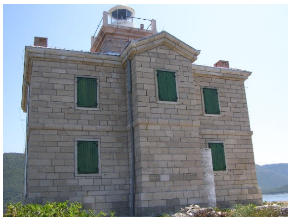
Slika 80 Stražnja strana svjetionika na hridi Zaglav
