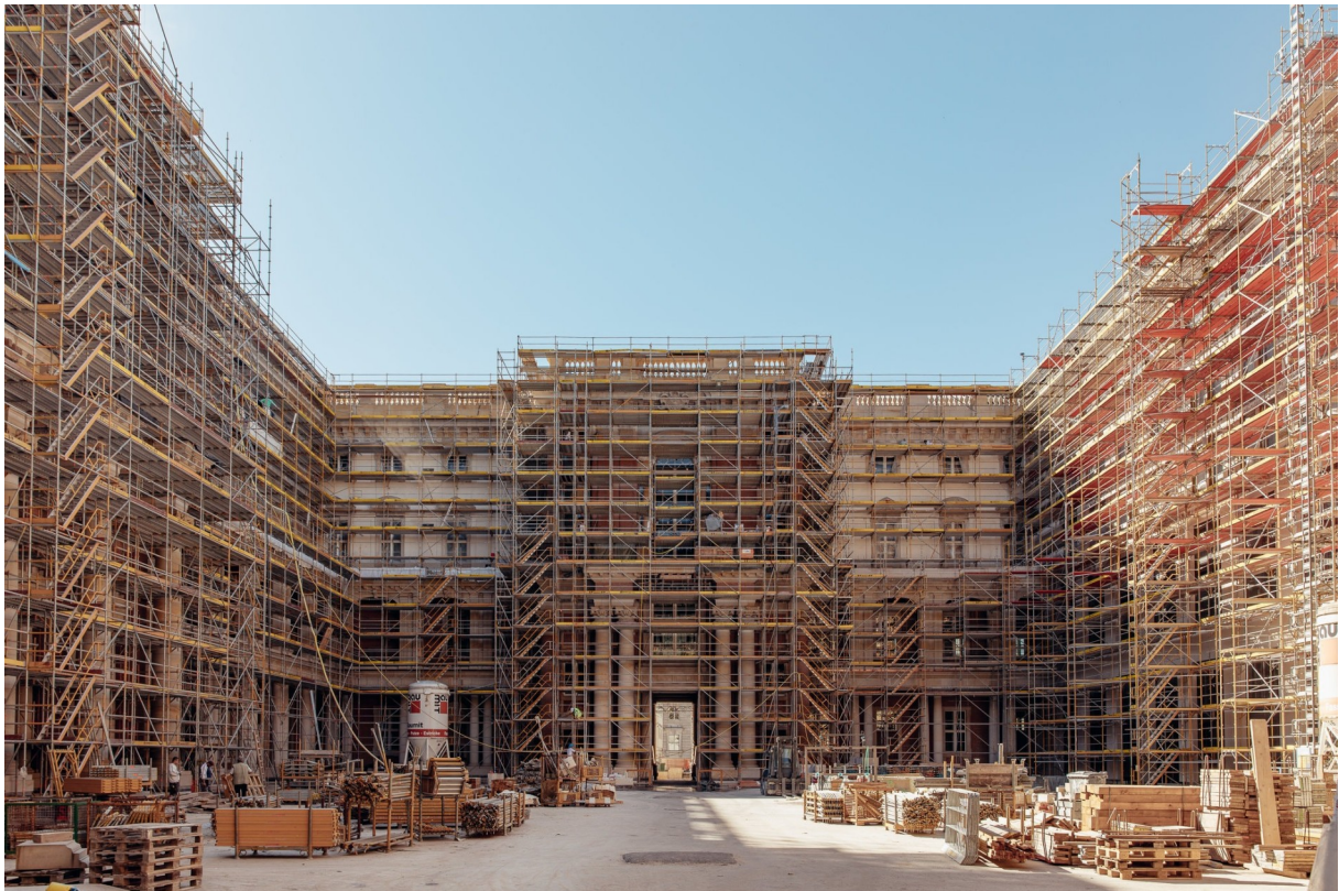
1. Dvorište Humboldtova foruma u vrijeme rekonstrukcije, srpanj 2018.
