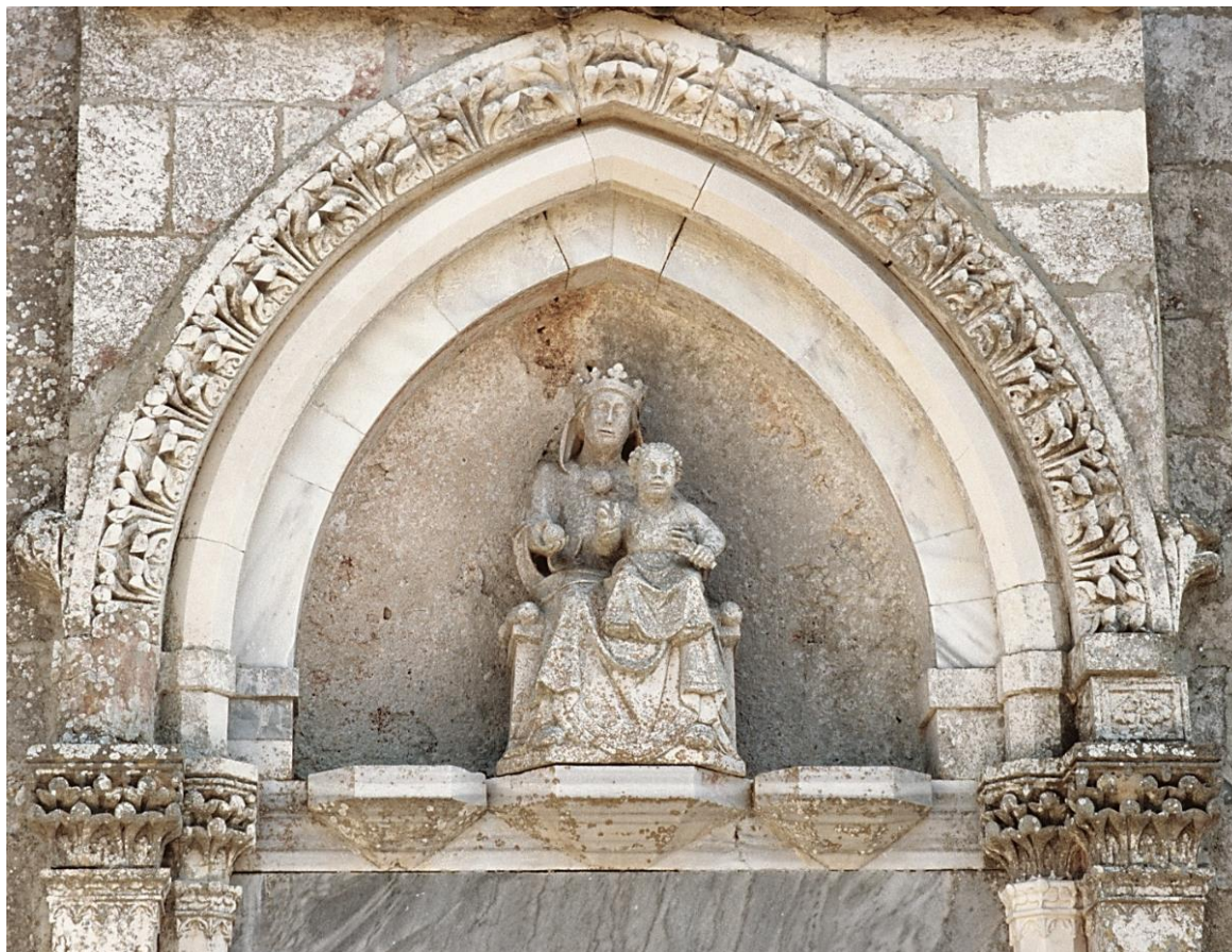
Luneta portala, sjeverno pročelje samostanske crkve sv. Kuzme i Damjana ( https://www.glas-koncila.hr/benediktinci-okupljaju-vjernike-na-cokovcu-crkva-sv-kuzme-i-damjana/ )
