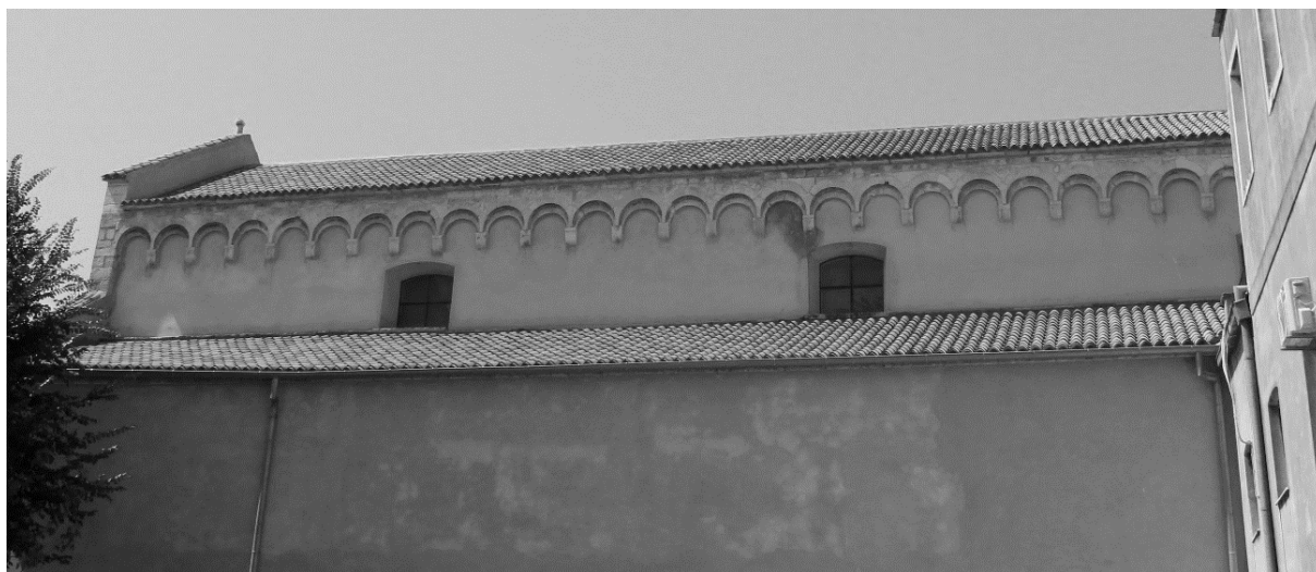
Sl. 2. Crkva Sv. Krševana, sjeverni zid (foto: M. Taradi)
