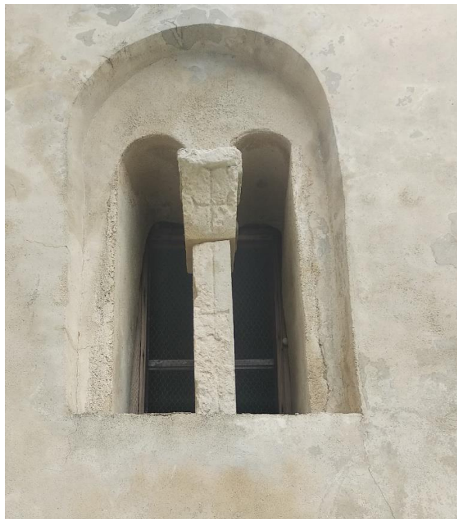
Slika 21. Bifora na pročelju crkve sv. Andrije (Vrgada) Foto: Filip Lovrić
