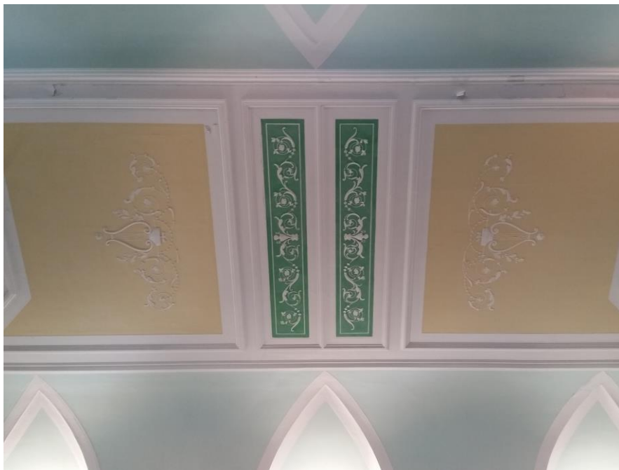
Slika 8. Detalj svoda glavnoga broda
