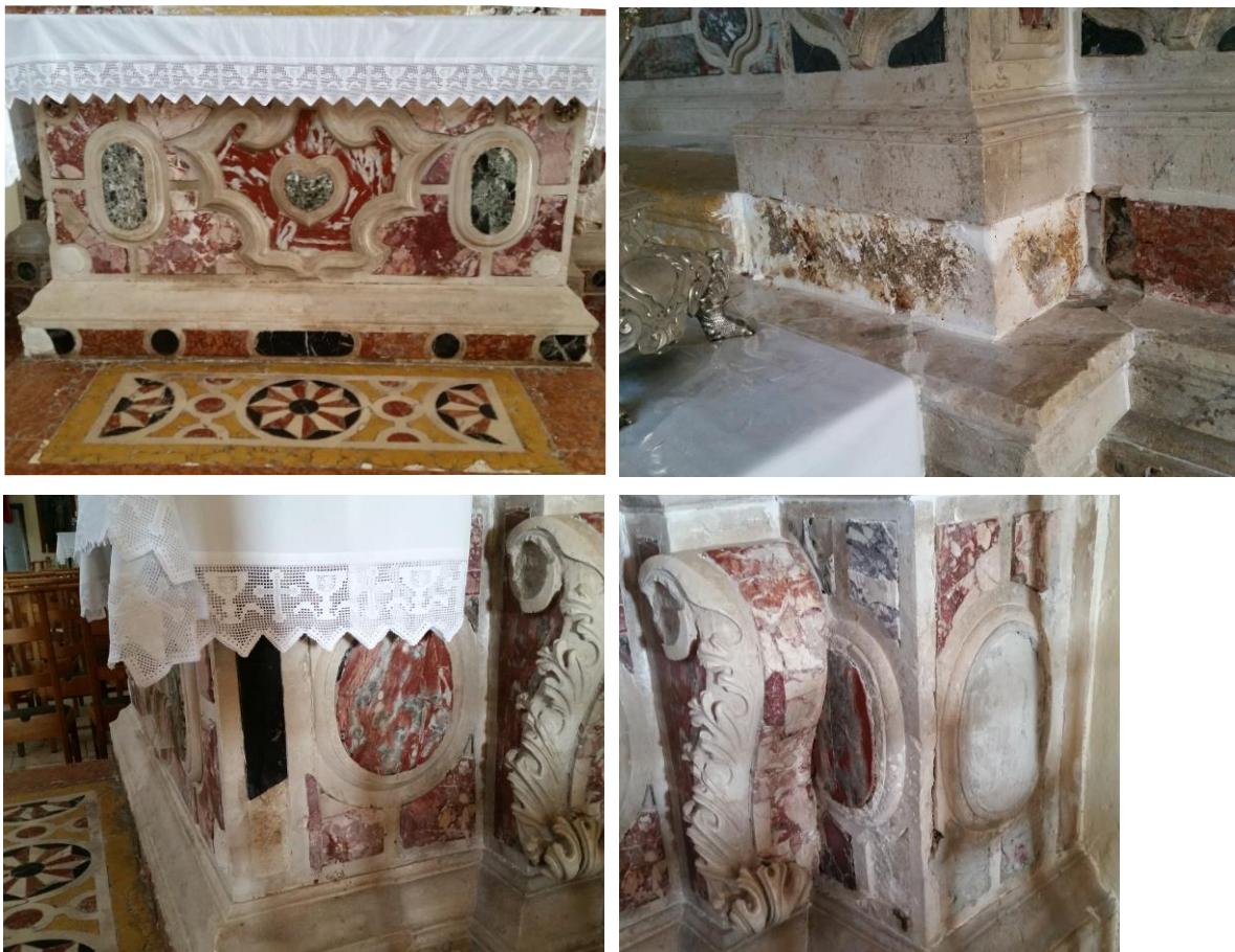
Slika 38. Degradacija zapadnog oltara južnog broda
