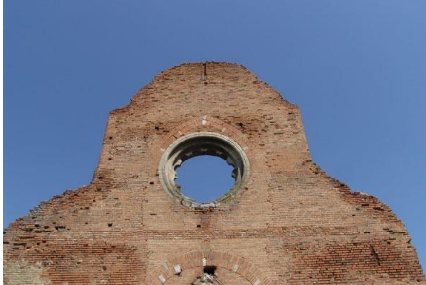
Sl. 27 Zapadno pročelje s rozetom
