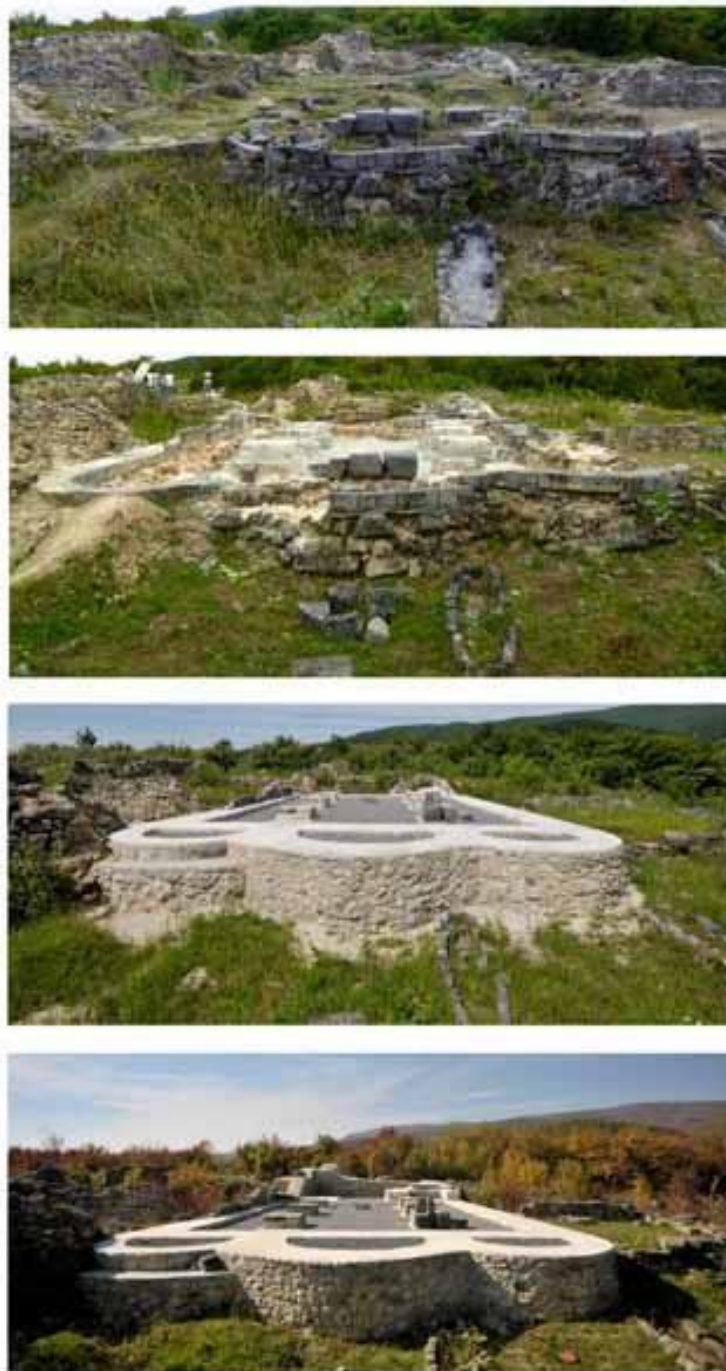
Sl. 7 Pogled s istoka na rudinsku opatijsku crkvu prije, tijekom i nakon prve faze konzervatorsko-restauratorskih građevinskih radova
