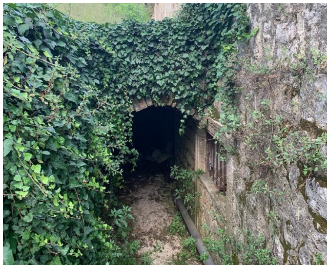
101. Volat i prozor prizemlja, sjeverna strana, kompleks Baletin, Zastolje, snimljeno 2019.
