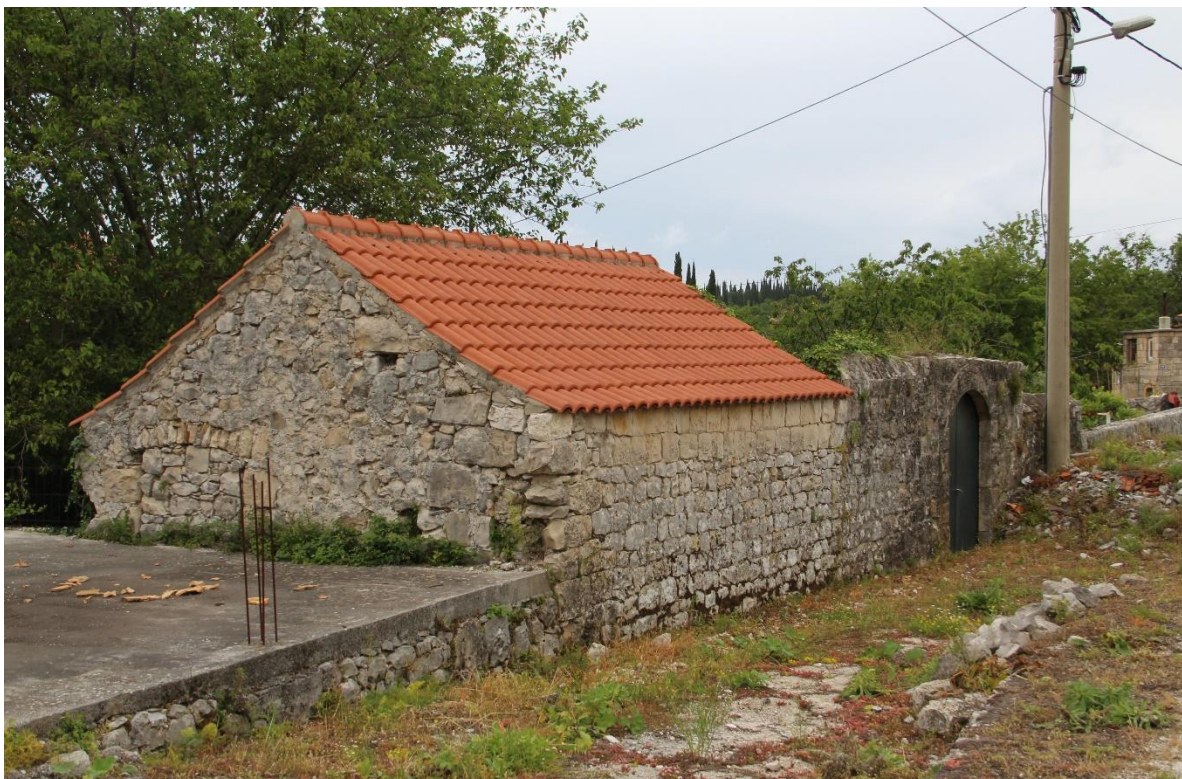
45. Ostaci ogradnog zida, portal, gospodarska građevina i temelji druge gospodarske građevine, kompleks Bunić, Čilipi, snimljeno 2019.
