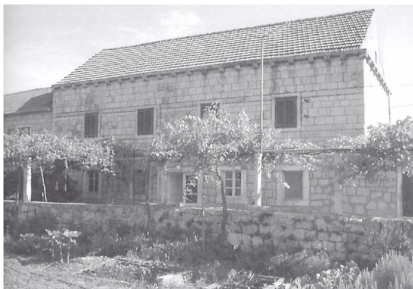
50. Pročelje stambene građevine kompleksa Getaldić, Čilipi, snimljeno 2004.
