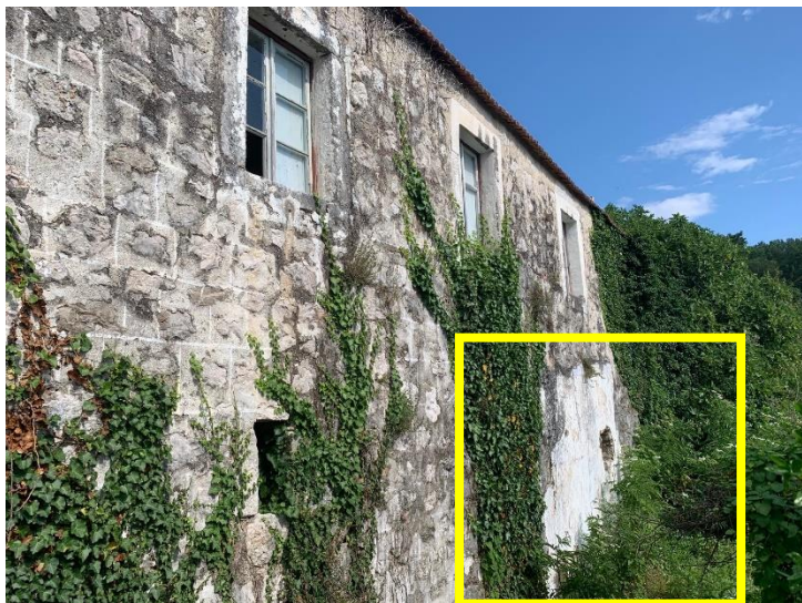
100. Južna strana jednokatnice s označenim mjestom gdje se nekada kapelica naslanjala na građevinu, kompleks Baletin, Zastolje, snimljeno 2019.
