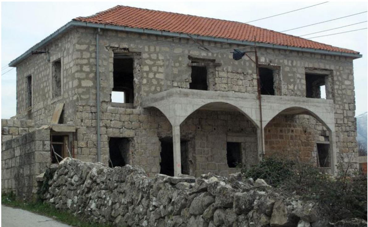
72. Obnova stambene jednogatnice kompleksa Natalić, Močići, snimljeno 2007.
