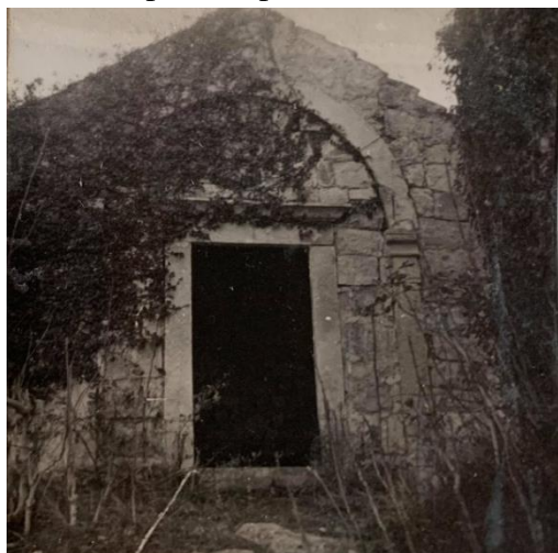
21. Kapelica sv. Antuna, kompleks Kabužić, Čilipi (Miočići), snimljeno 1969.
