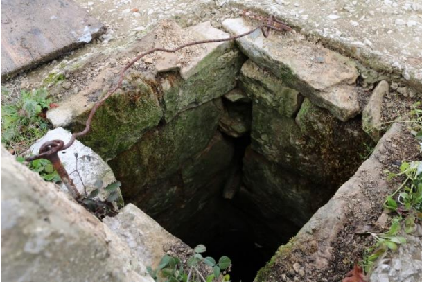
79. Cisterna kompleksa Bunić, Močići
