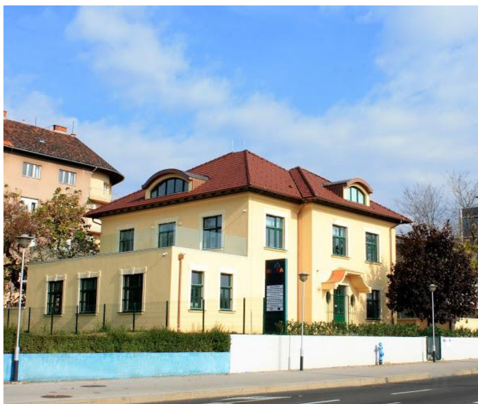
Slika 18. Zgrada poliklinike Helena (jugozapadna strana)
