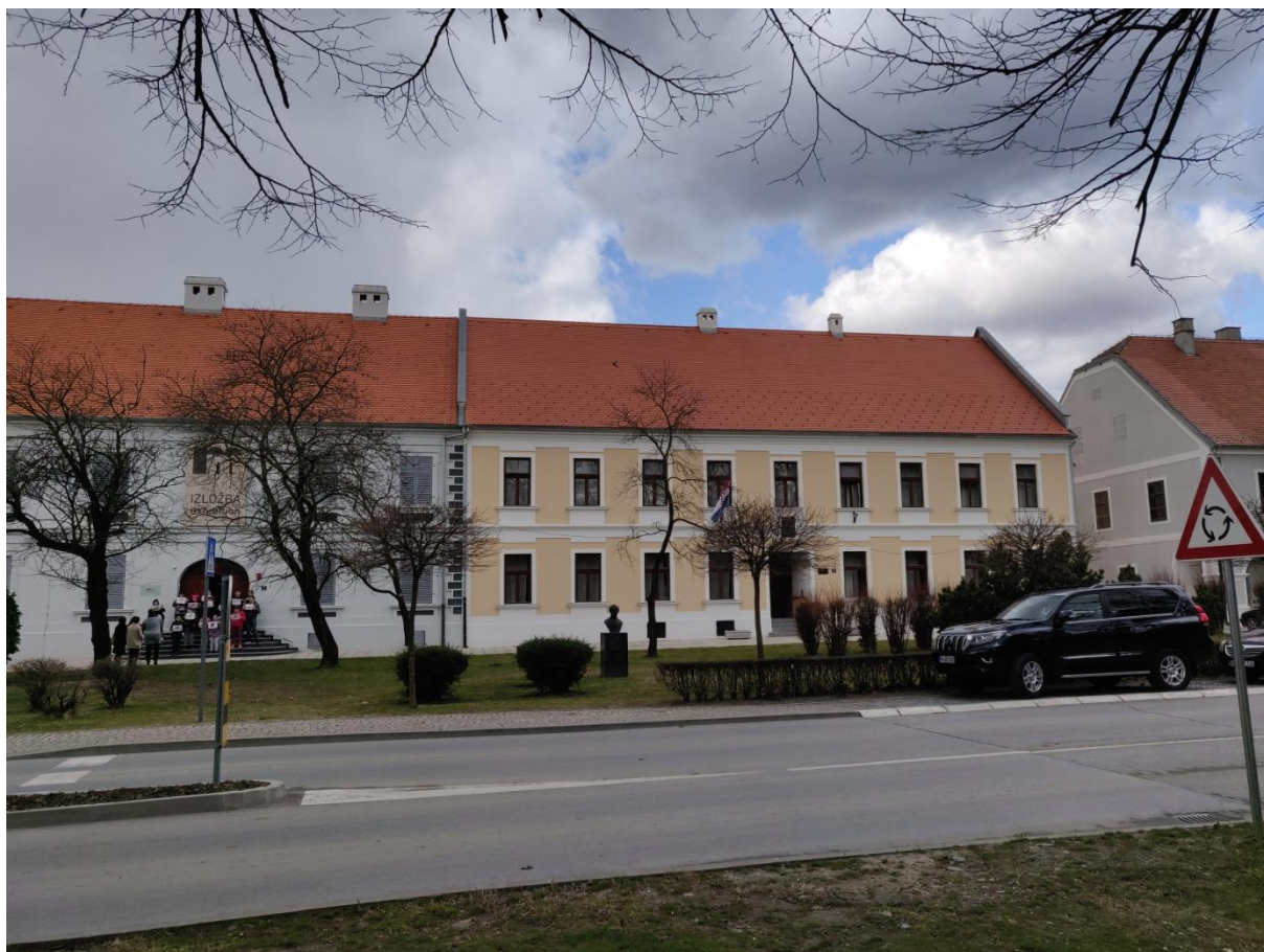
Slika br. 11 Zgrada Općinskog suda nakon obnove (fotografirano 28. veljače 2020.)
