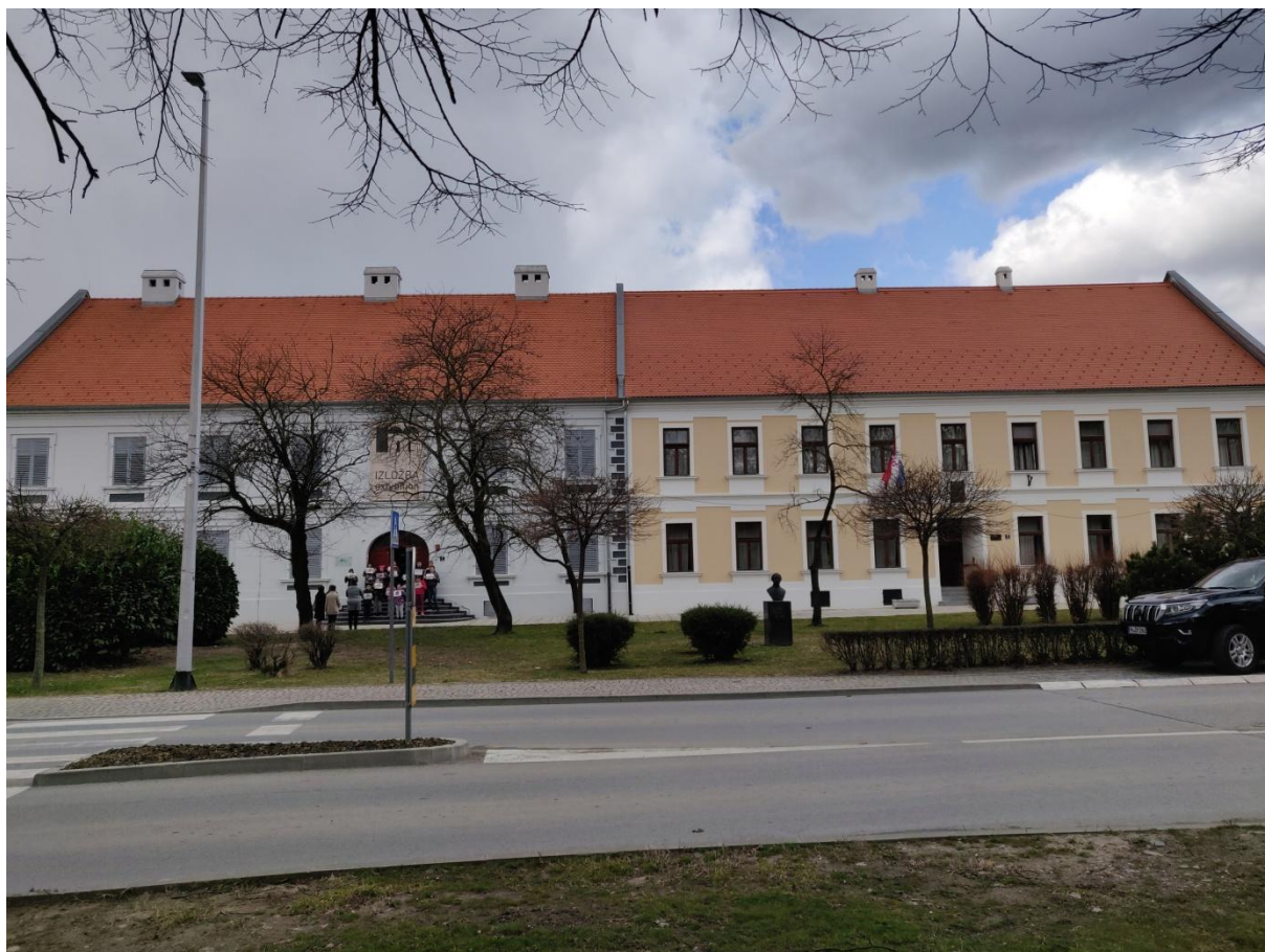
Slika br. 13 Zgrade Gradskog muzeja (lijevo) i Općinskog suda (desno) nakon obnove (fotografirano 28. veljače 2020.)
