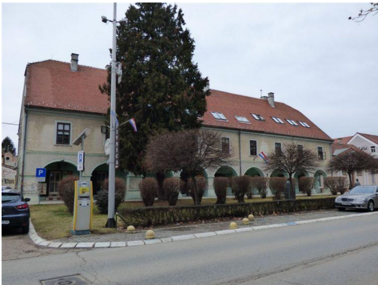
Slika br. 8 Zgrada Starog suda prije obnove (izvor: https://www.novagra.hr/pocinju-radovi-na-obnovi-procelja-zgrade-starog-suda/ )
