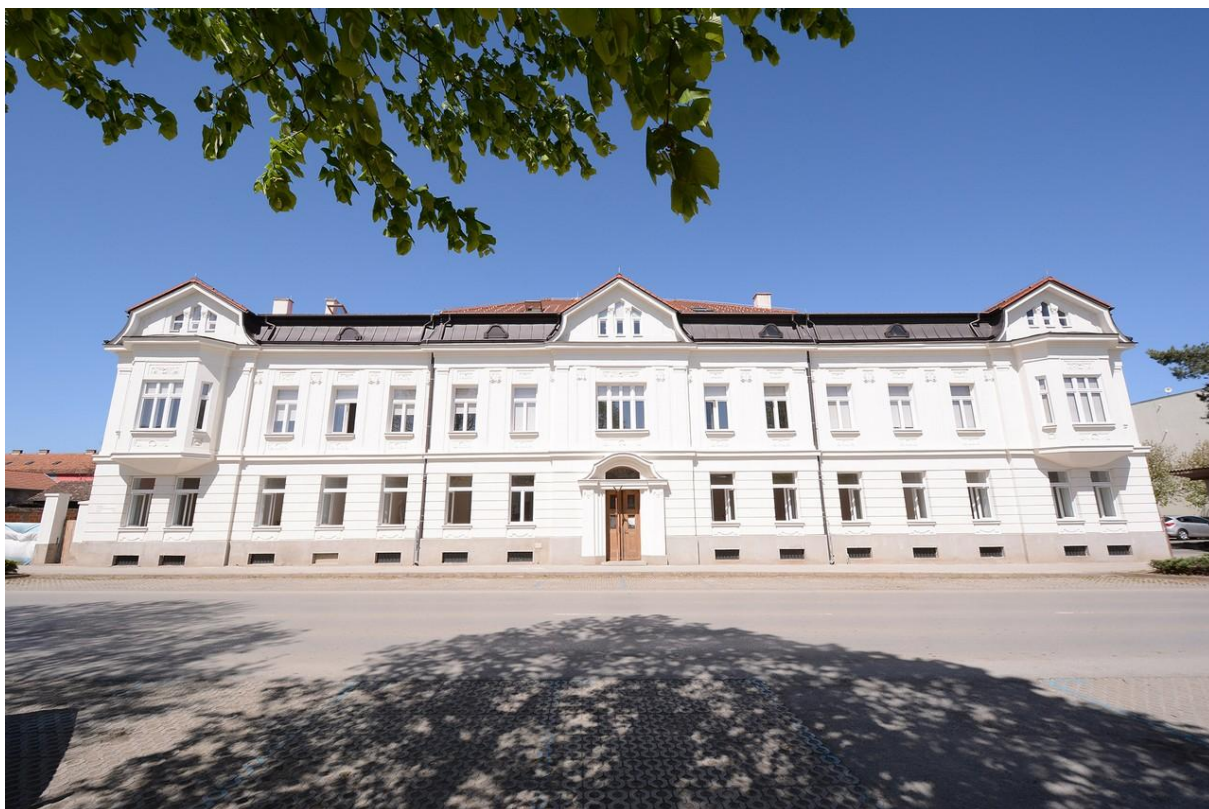
Slika br. 21 Zgrada Direkcije šuma (izvor: http://tzng.hr/fotogalerija/nggallery/page/4 )
