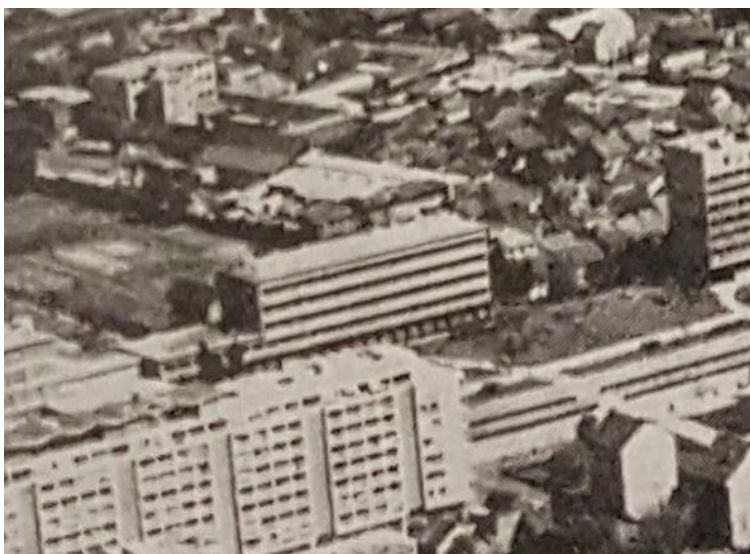
Slika 1. Sklop upravnih zgrada MUP-a RH 214
