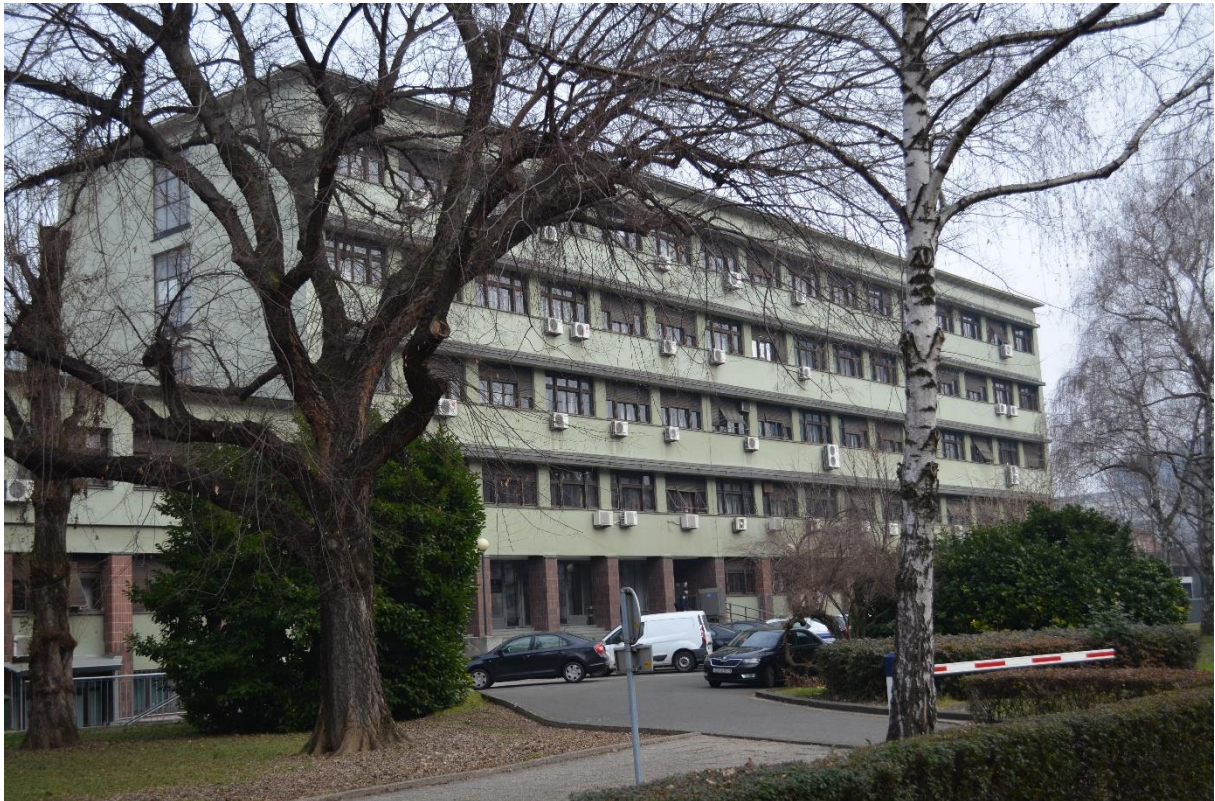
Slika 2. Sklop upravnih zgrada MUP-a RH 215
