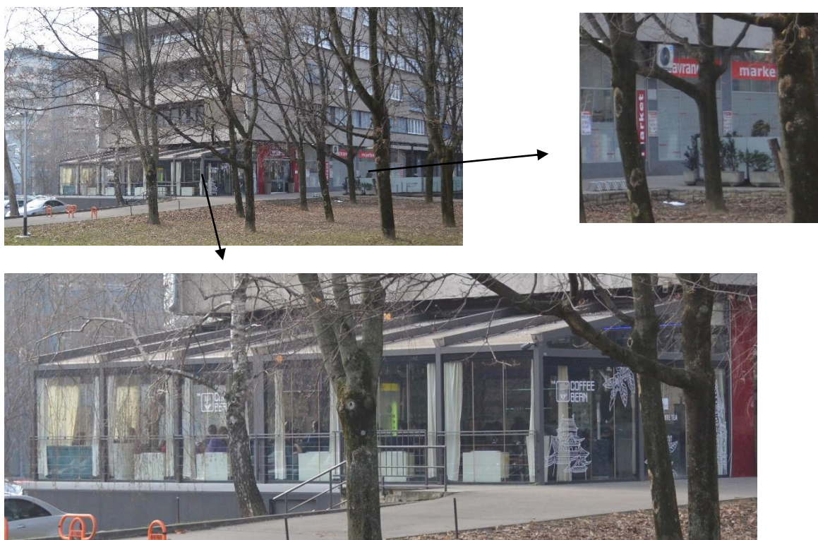
Slika 29. Višestambena zgrada Kruge, Ulica grada Vukovara 222-224, bočni prikaz 260
