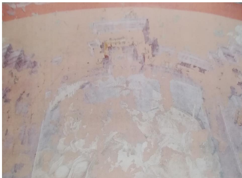
Slika 38. Stanje zidnog oslika prije konzervatorsko-restauratorskih radova
