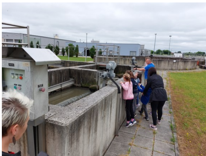
Slika 5. Posjet Uređaju za pročišćavanje vode
