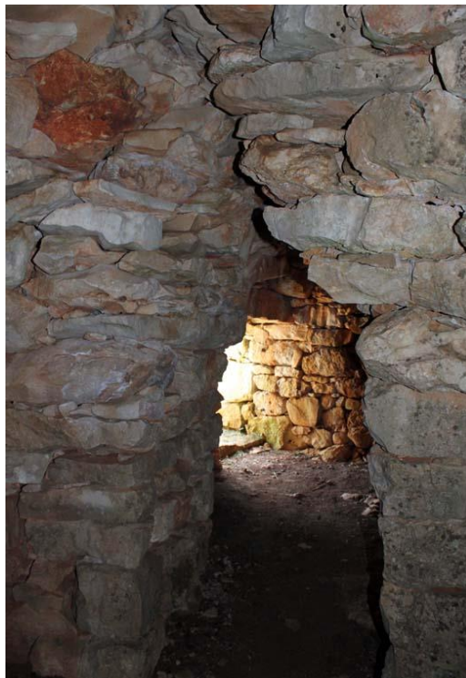
Slika 77: Nepravilno svođeni prolaz
