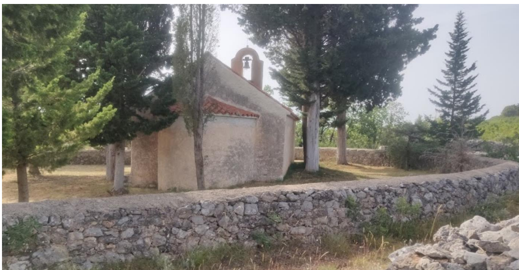
Slika 35: Začelje crkve sv. Ilije Proroka ograđene ovalnim zidom
